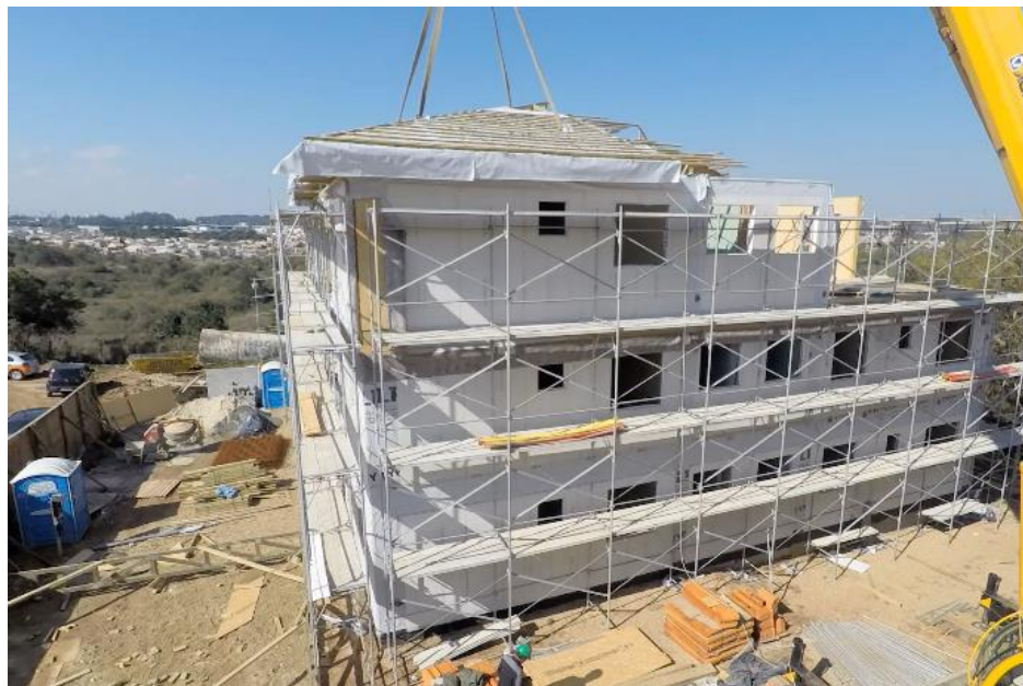
Figura 2 – Prédio em wood frame , em Araucária Fonte: Tecverde (2016b).
