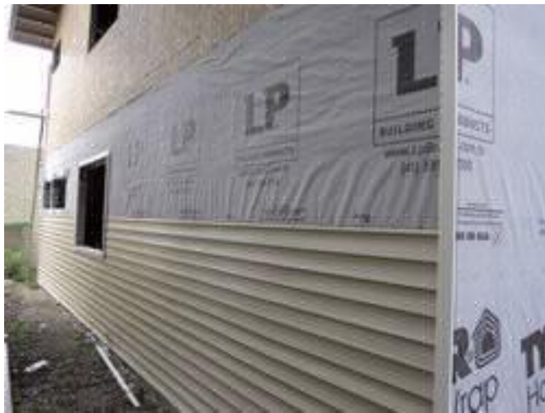
Figura 9 - Membrana de impermeabilização e siding de PVC Fonte: TÉCHNE (2013).
