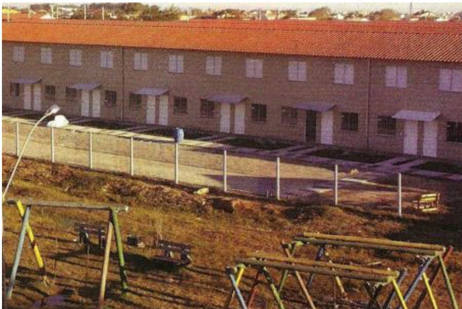
Figura 1 – Condomínio MCMV em wood frame , em Pelotas Fonte: Construção Mercado (2013).
