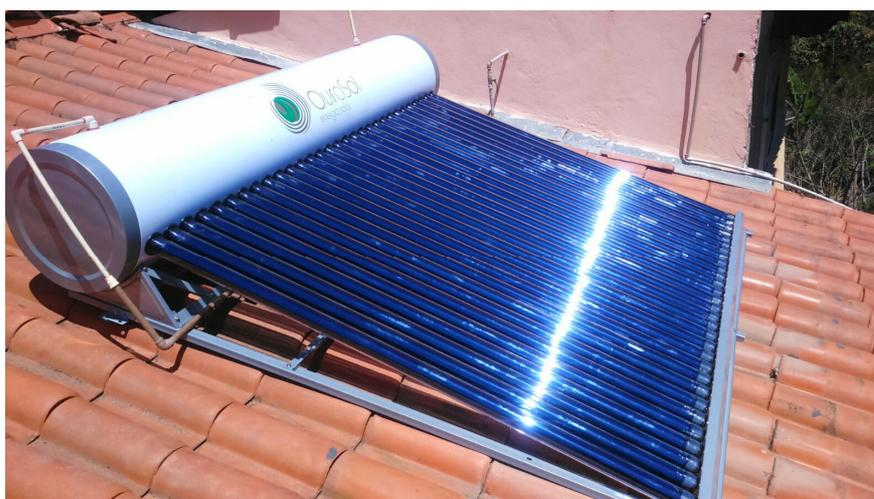
**Figura 6 – Armazenamento integrado**
