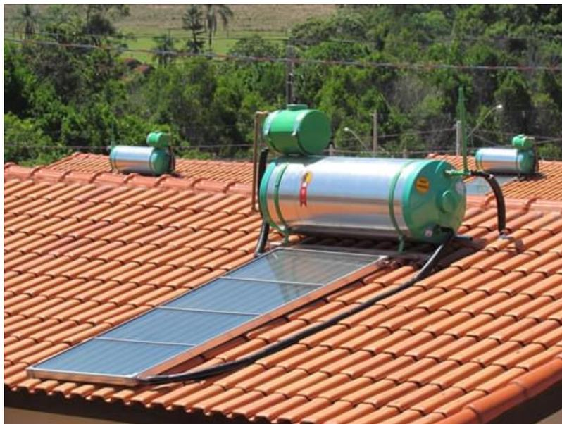
**Figura 5 – Armazenamento acoplado**
