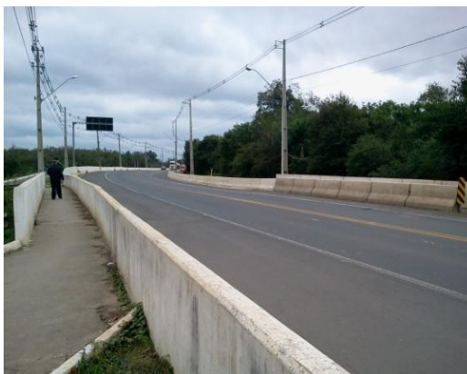
Figura 39 – Vista frontal da ponte alargada sobre o rio Maciel Fonte: AAD Projetos Consultoria e Engenharia.
