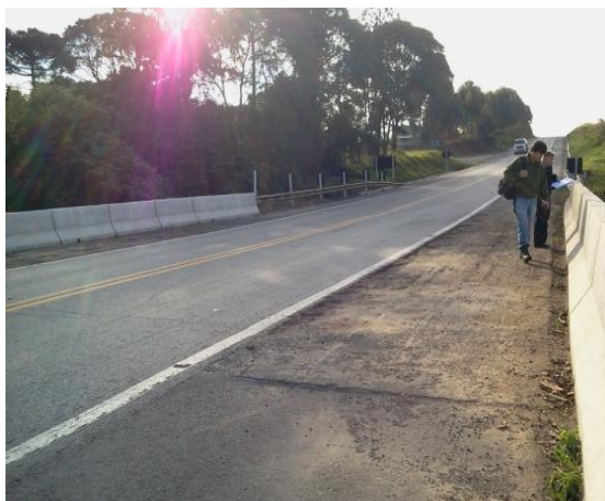
Figura 31 – Vista frontal da ponte original sobre o rio Passa Dois Fonte: AAD Projetos Consultoria e Engenharia.
