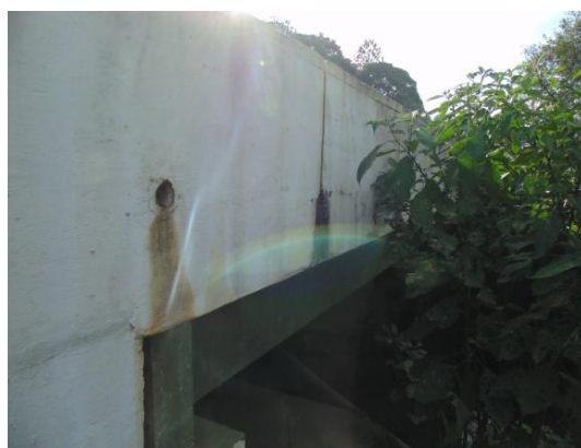
Figura 32 – Vista lateral da ponte original sobre o rio Passa Dois Fonte: AAD Projetos Consultoria e Engenharia.
