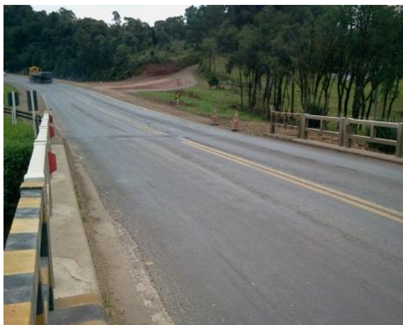
Figura 43 – Vista frontal da ponte original sobre o rio Macacos Fonte: AAD Projetos Consultoria e Engenharia.
