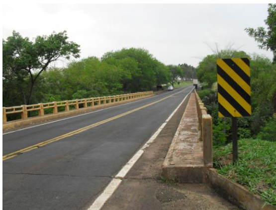
Figura 25 – Vista frontal da ponte original sobre o rio Tigre Fonte: AAD Projetos Consultoria e Engenharia.
