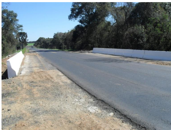
Figura 30 – Vista frontal da ponte sobre o banhado do rio Iguaçu após a execução do alargamento
