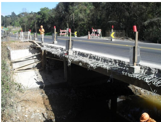
Figura 29 – Vista lateral da ponte sobre o banhado do rio Iguaçu durante a execução do alargamento
