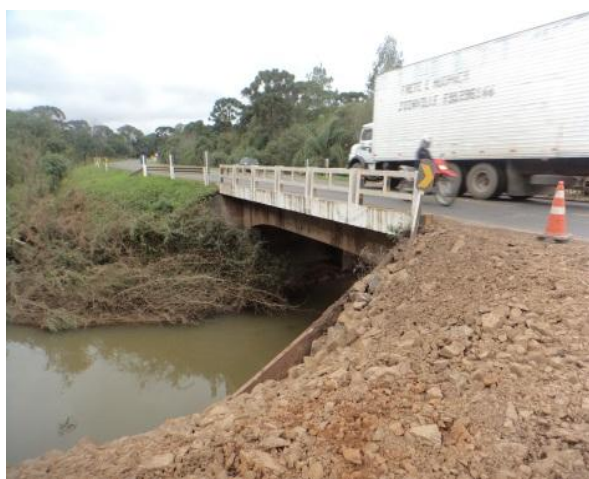
Figura 44 – Vista lateral da ponte original sobre o rio Macacos Fonte: AAD Projetos Consultoria e Engenharia.
