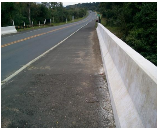
Figura 35 – Vista frontal da ponte alargada sobre o rio Água Amarela II Fonte: AAD Projetos Consultoria e Engenharia.
