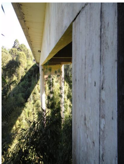
Figura 42 – Vista inferior da ponte original sobre o rio Espingarda Fonte: AAD Projetos Consultoria e Engenharia.
