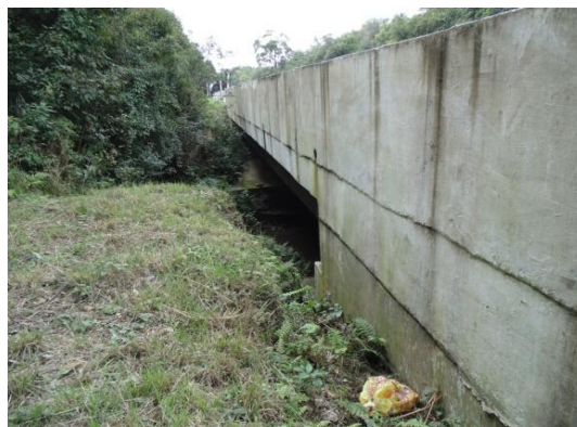
Figura 36 – Vista lateral da ponte alargada sobre o rio Água Amarela II Fonte: AAD Projetos Consultoria e Engenharia.
