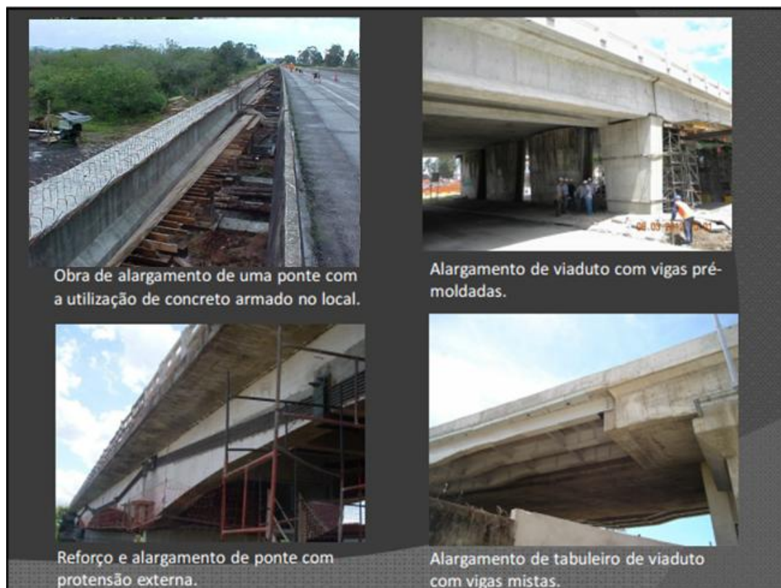
Figura 13 – Métodos de alargamentos de pontes de concreto Fonte: Adaptado de VITÓRIO (2013).
