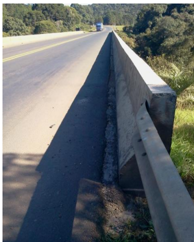
Figura 41 – Vista frontal da ponte original sobre o rio Espingarda Fonte: AAD Projetos Consultoria e Engenharia.
