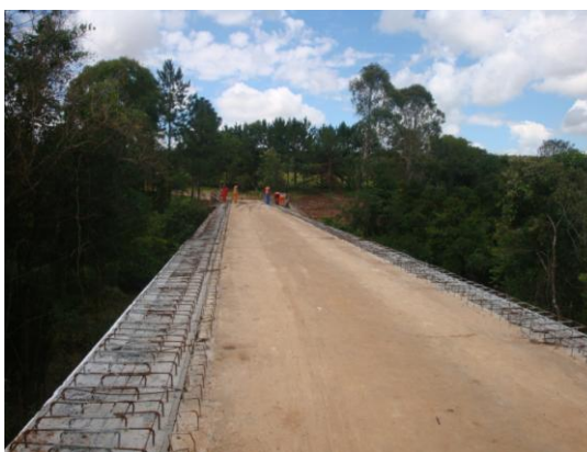
Figura 28 – Vista frontal da ponte sobre o rio Fortaleza durante a execução de reforço e alargamento Fonte: AAD Projetos Consultoria e Engenharia.
