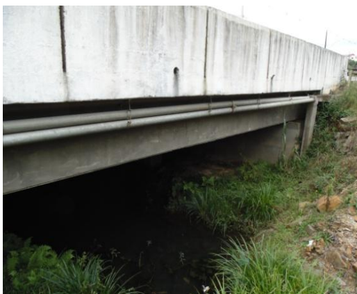
Figura 40 – Vista lateral da ponte alargada sobre o rio Maciel Fonte: AAD Projetos Consultoria e Engenharia.
