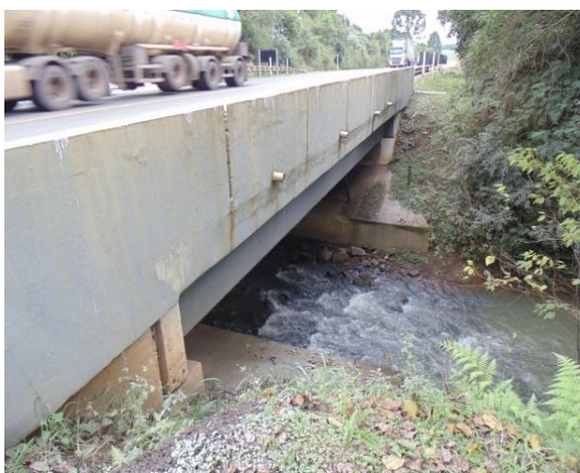
Figura 38 – Vista lateral da ponte alargada sobre o rio Vargem Grande Fonte: AAD Projetos Consultoria e Engenharia.
