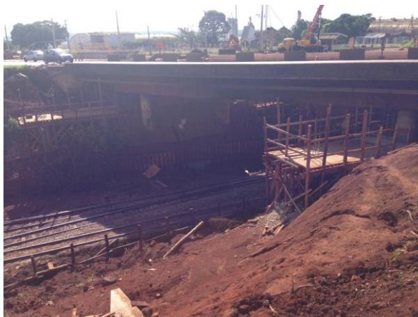
Figura 23 – Vista lateral do viaduto na Rodovia PR 323 em fase de execução do alargamento Fonte: AAD Projetos Consultoria e Engenharia.
