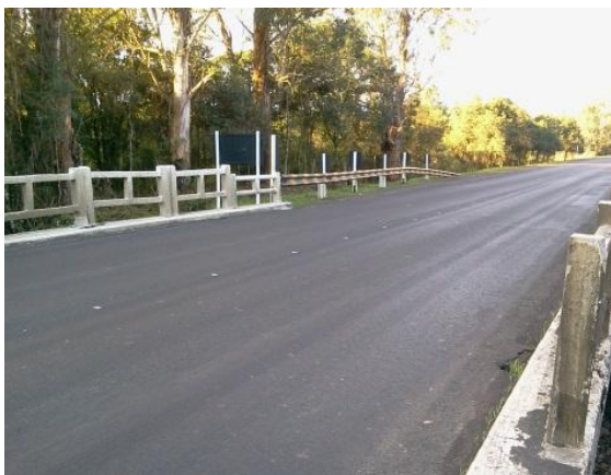
Figura 53 – Vista frontal da ponte original sobre o rio Carazinho Fonte: AAD Projetos Consultoria e Engenharia.
