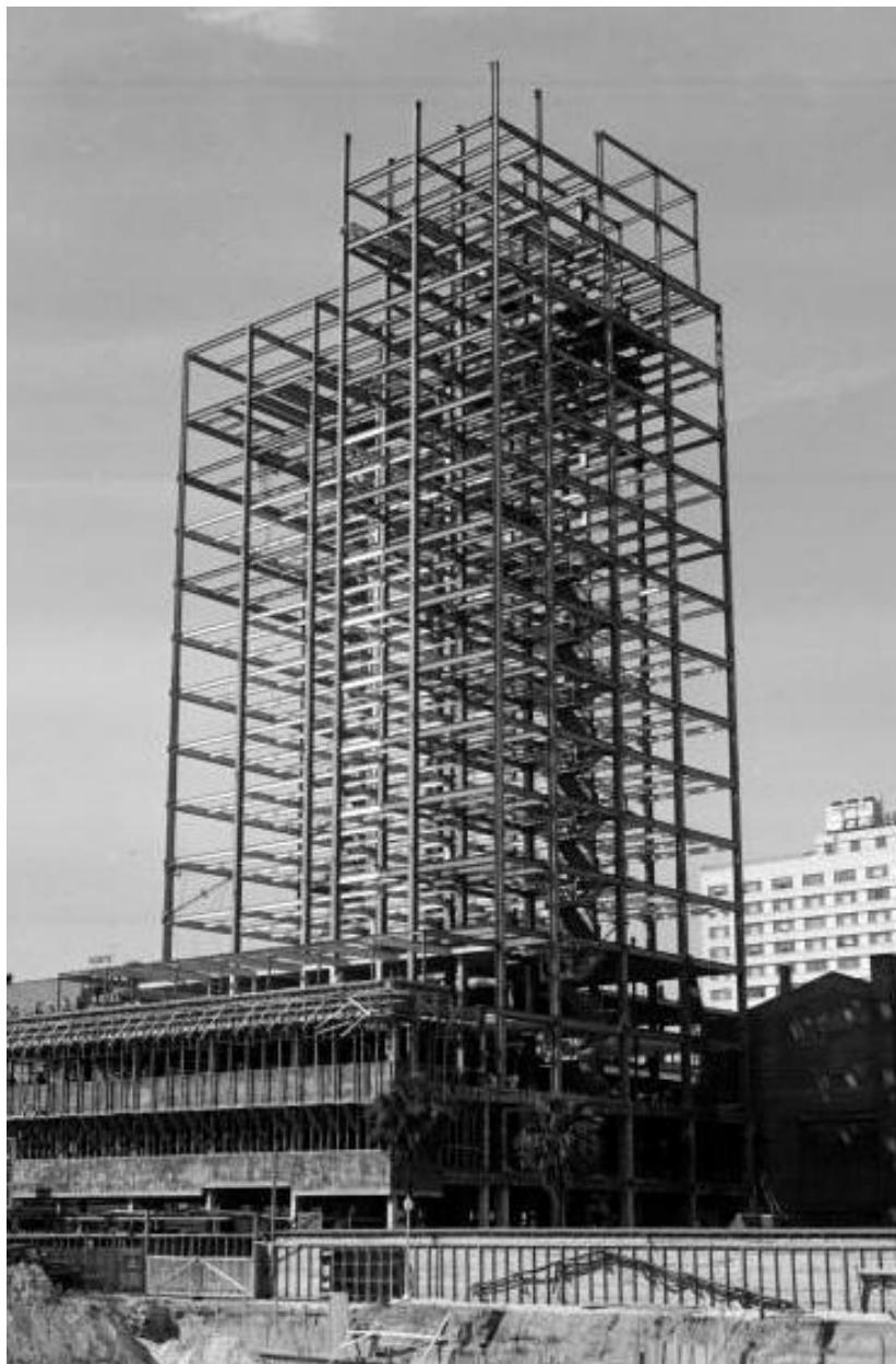
Figura 6 – Construção do edifício Independent Life and Accident Insurance Company home office
