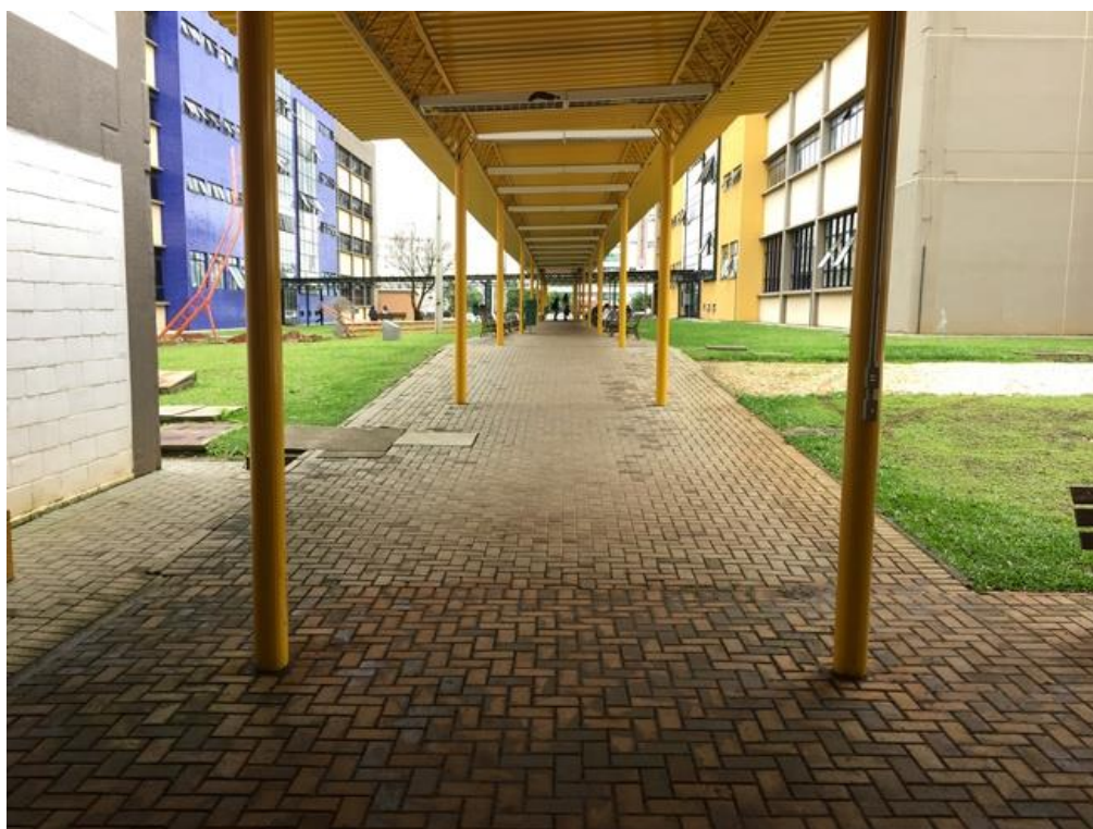
Figura 20 – Detritos visíveis em área pavimentada
