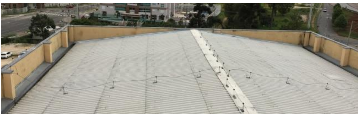
Figura 26 – Parte do telhado da cobertura do bloco B
