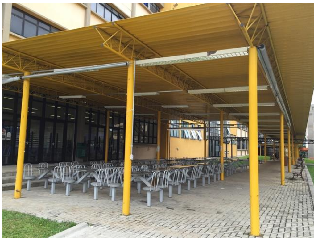
Figura 18 - Área coberta com pavimentação em blocos de concreto intertravados Fonte: Acervo próprio
