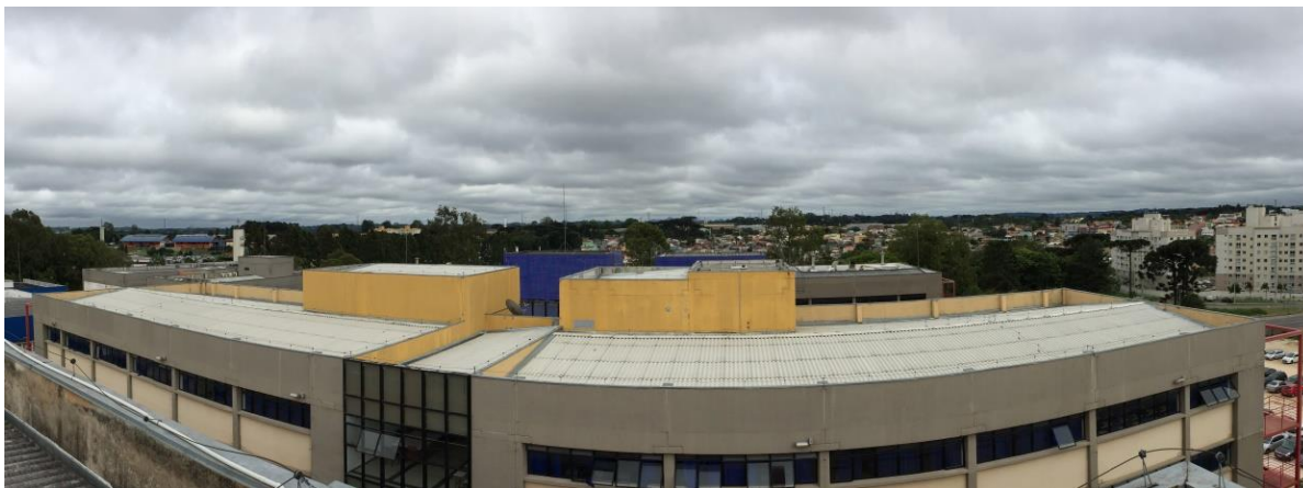
Figura 25 – Imagem panorâmica da cobertura do bloco B
