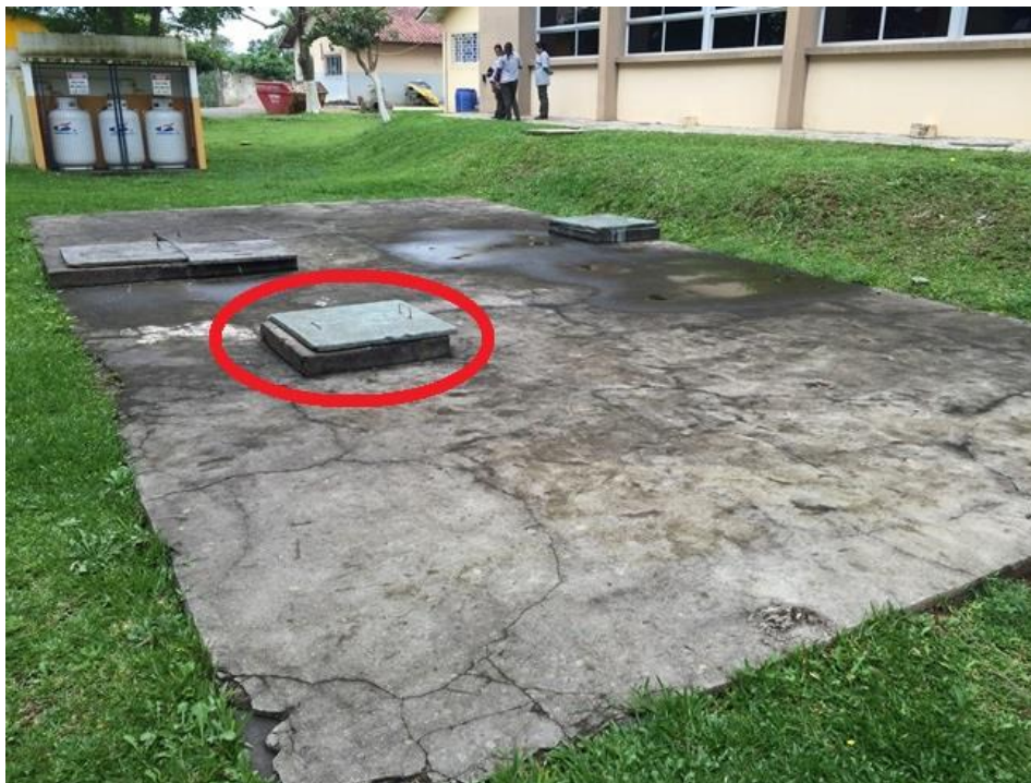
Figura 29 – Indicação do alçapão de acesso à cisterna de água de chuva
