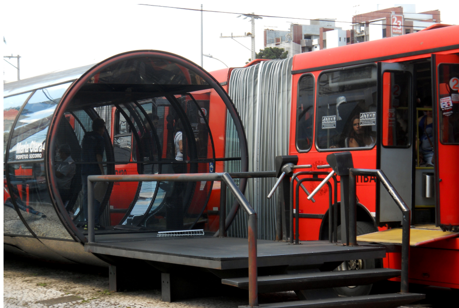
Fotografia 3 – Rampa de desembarque em nível. Fonte: Autoria própria, 2013.
