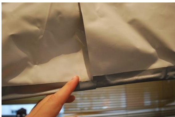
Figura 57 – Problemas encontrados Fonte: Fotografado por Diego Mafioletti (2011).
