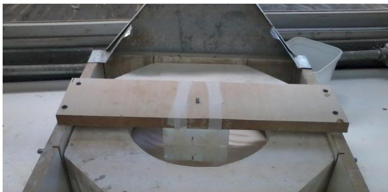
**Figura 130 - Blocos de isopor no interior do molde**
