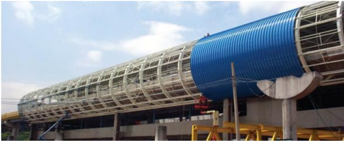
Figura 22- Cobertura metálica com detalhe do seu fechamento. Fonte: Figueiredo Ferraz, 2009
