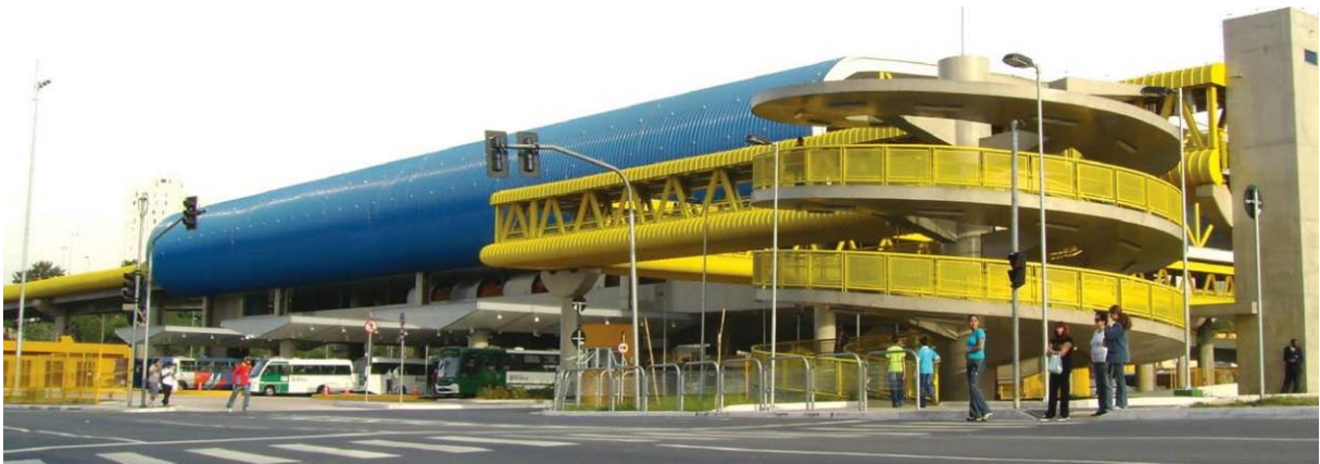
Figura 16- Terminal Sacomã. Fonte: www.figueiredoferraz.com.br
