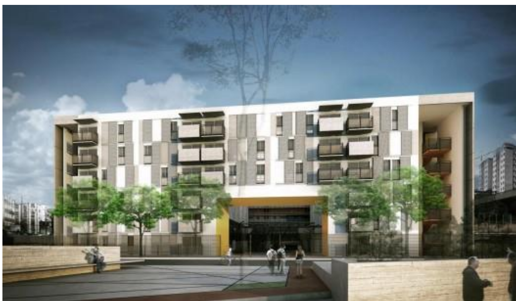
Figura 14 - Perspectiva externa do Conjunto Habitacional Heliópolis. Fonte: HELM, 2013.
