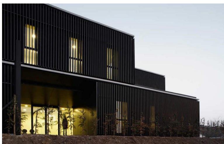
Figura 4: Shelter Home - Vista Fachada
