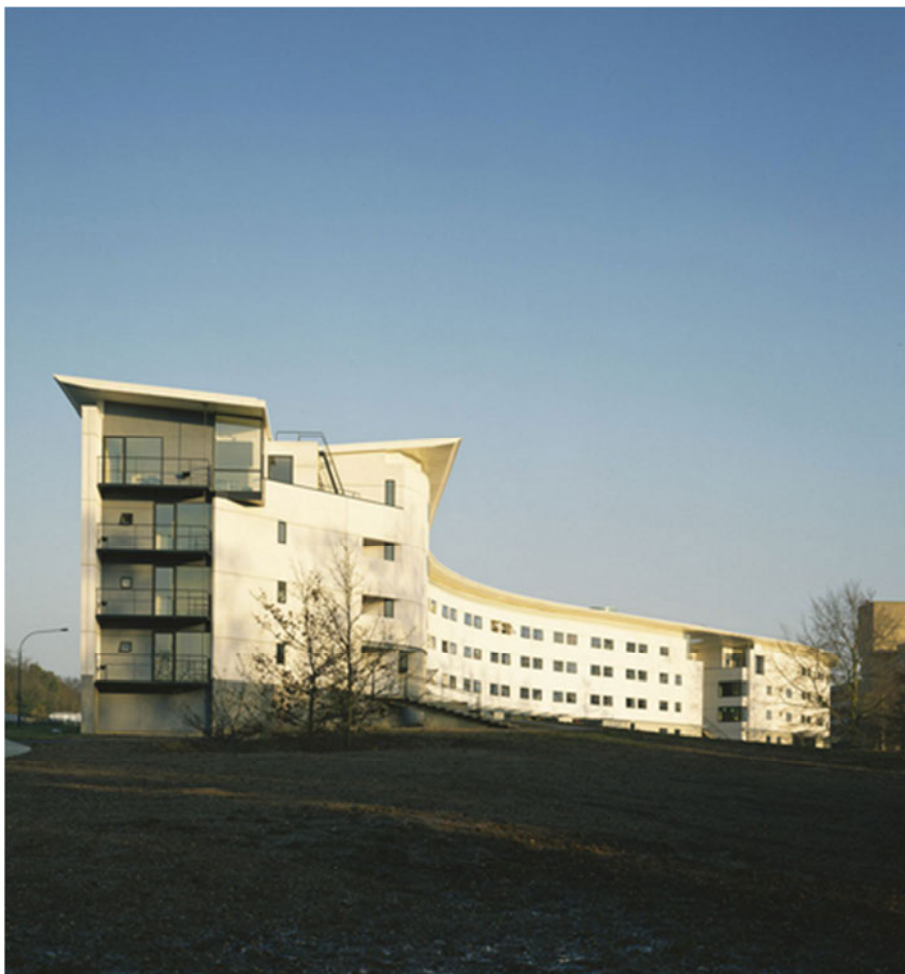
Figura 21 - Foto externa. Constable Terrace, University of East Anglia, Norwich, Reino Unido. Fonte: RICK MATHER ARCHITECTS, 1993.
