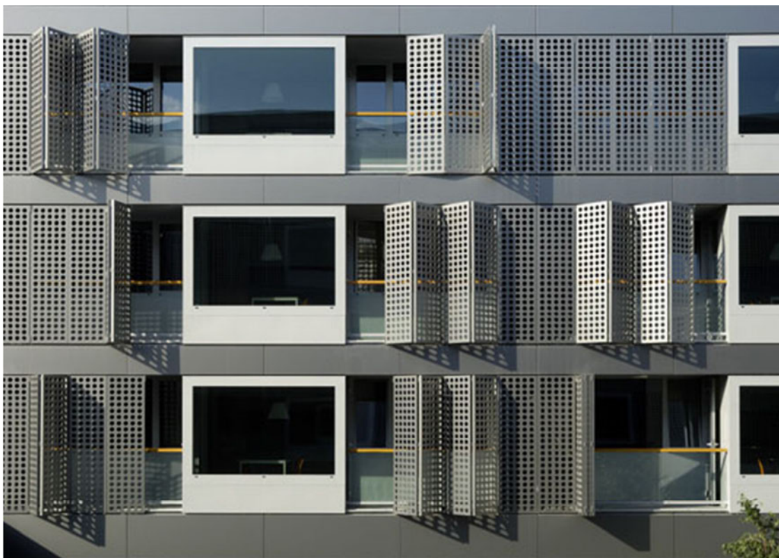
Figura 38 - Foto da fachada. Residência Universitária Poljane. Ljubljana, Eslovênia. As unidades habitacionais possuem tratamento de fachada com chapa perfurada, garantindo privacidade e, ao mesmo tempo, uma semi-permeabilidade visual para quem está dentro dos quartos. Fonte: EFERIN.
