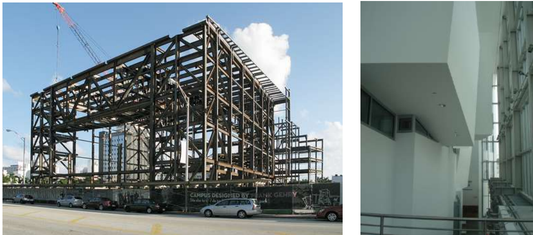
Figura 9 – Construção da estrutura externa. Fonte: ADF Group, 2011.
