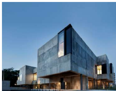
Fotografia 13 - Pavimento térreo sobre pilotis. Fonte: Archdaily, editado pela autora.
