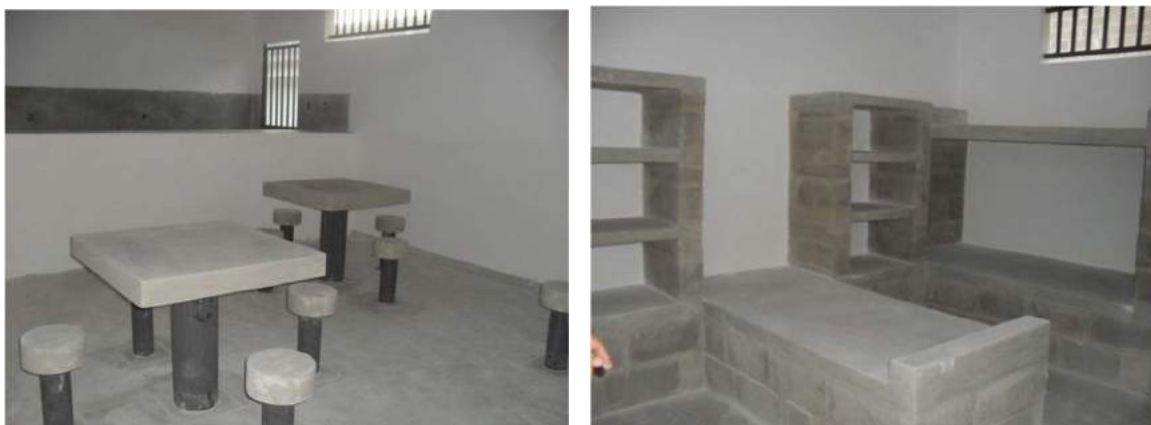
Figuras 11 e 12: Refeitório e quarto triplo do núcleo de moradia, em alvenaria. Fonte: (GOMES, 2011)
