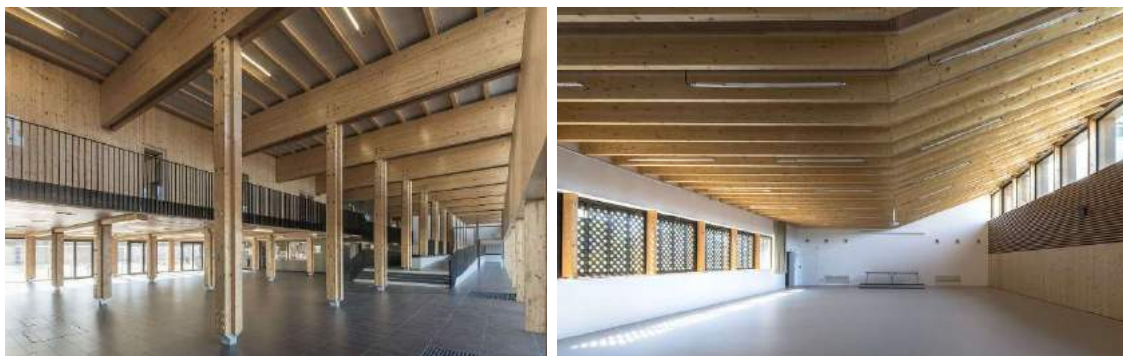
Figuras 32 e 33: Sistema viga-pilar no pátio e na quadra de esportes.
