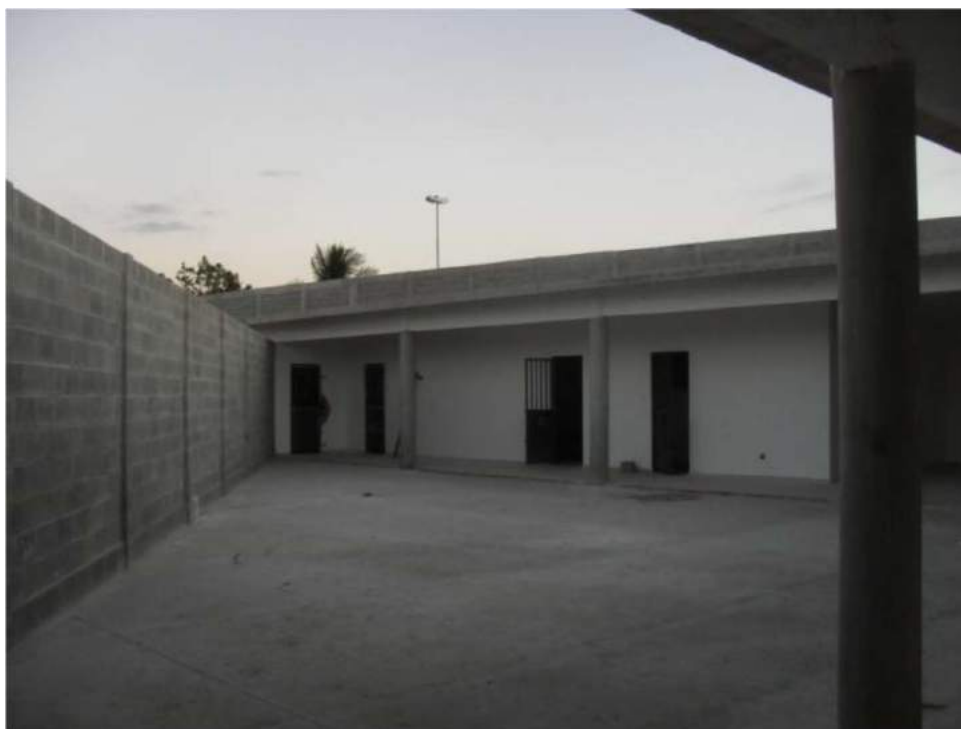
Figura 10: Núcleo de moradia (isolado por muros). Fonte: (GOMES, 2011)
