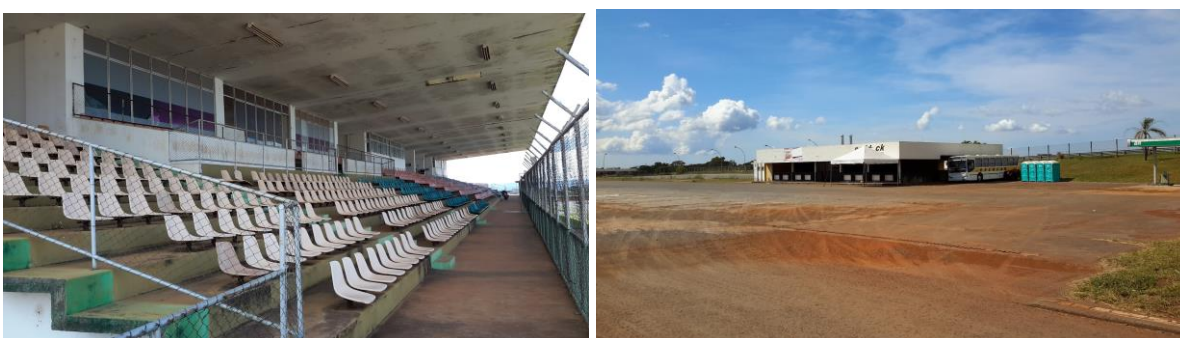
Figura 68 e Figura 69: Foto g - Arquibancada principal (à esquerda); Foto h - Área dos boxes e paddock atualmente (à direita)
