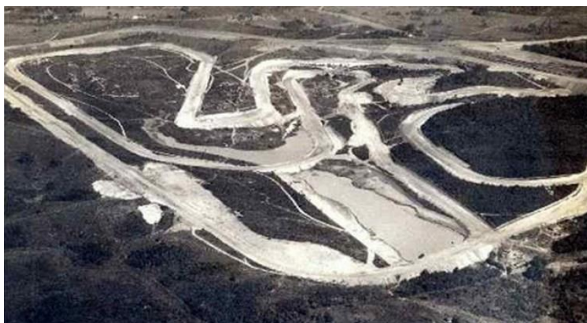
Figura 6: Vista aérea da construção de Interlagos
