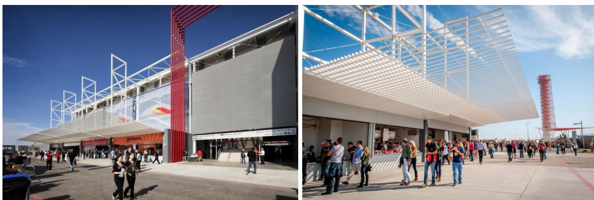
Figura 38: Arquibancada principal - Vista entrada.
