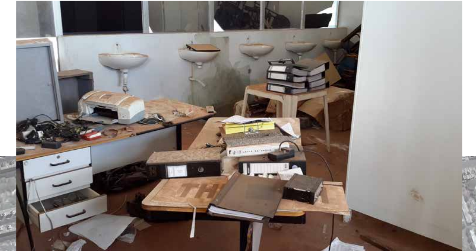
situação atual do banheiro da arquibancada principal
