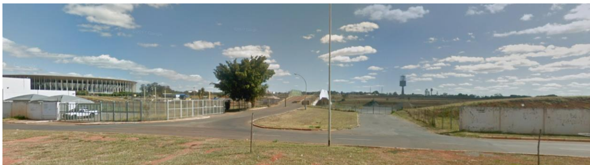
Figura 71: Vista SRPN, trecho 1 - Acesso ao autódromo
