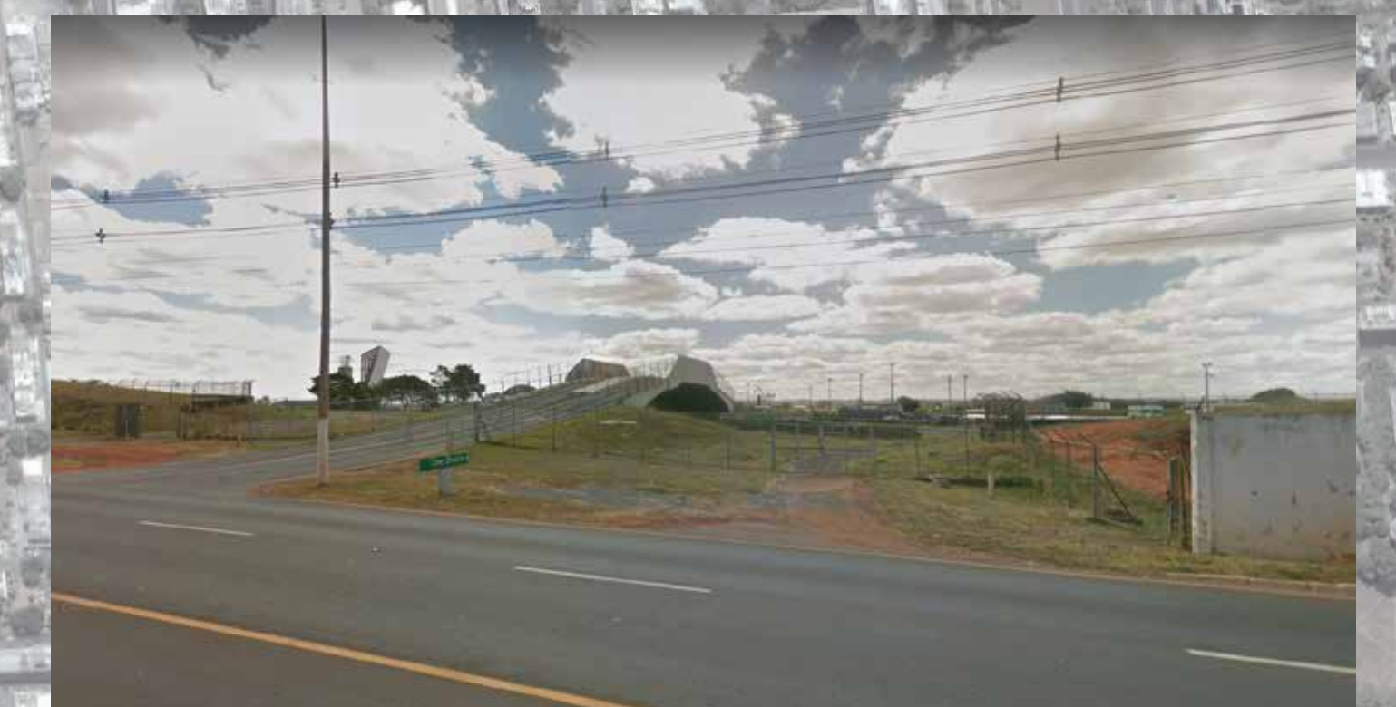
vista ponte principal - entrada pedestres e veículos
