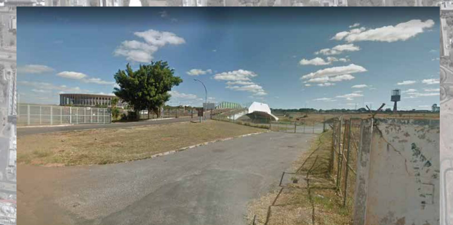
vista ponte principal - entrada pedestres e veículos
