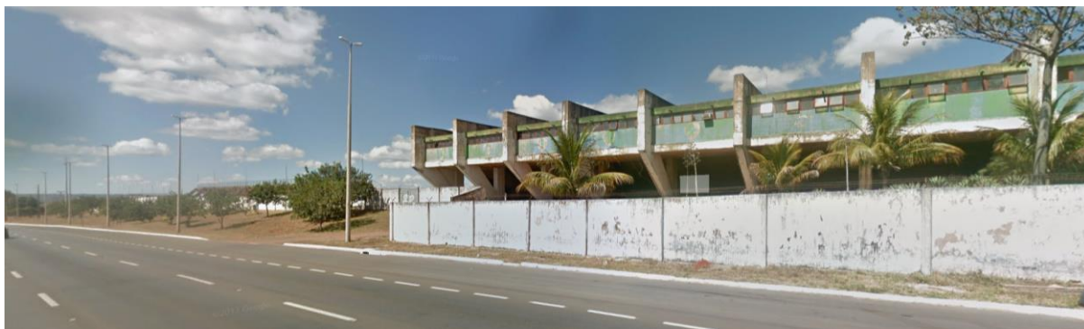
Figura 72: Vista SRPN, trecho 1 - Arquibancada
