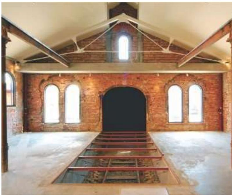
**Figura 14 – Lanternim, tesouras de aço e piso de vidro. Fonte: Dupré Arquitetura.**
