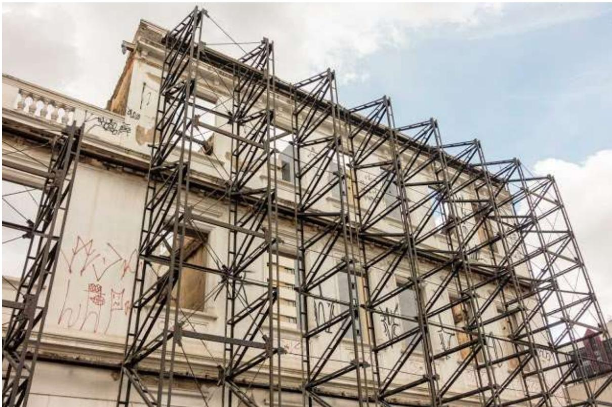
**Fotografia 20 - Escoras que sustentam a parede voltada para a Av. Sete de Setembro. Autoria: Fabio Ortolan. Fonte: Circulandocuritiba**
