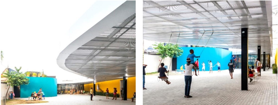
Figura 8 – Área de recreação coberta do Espaço Alana
