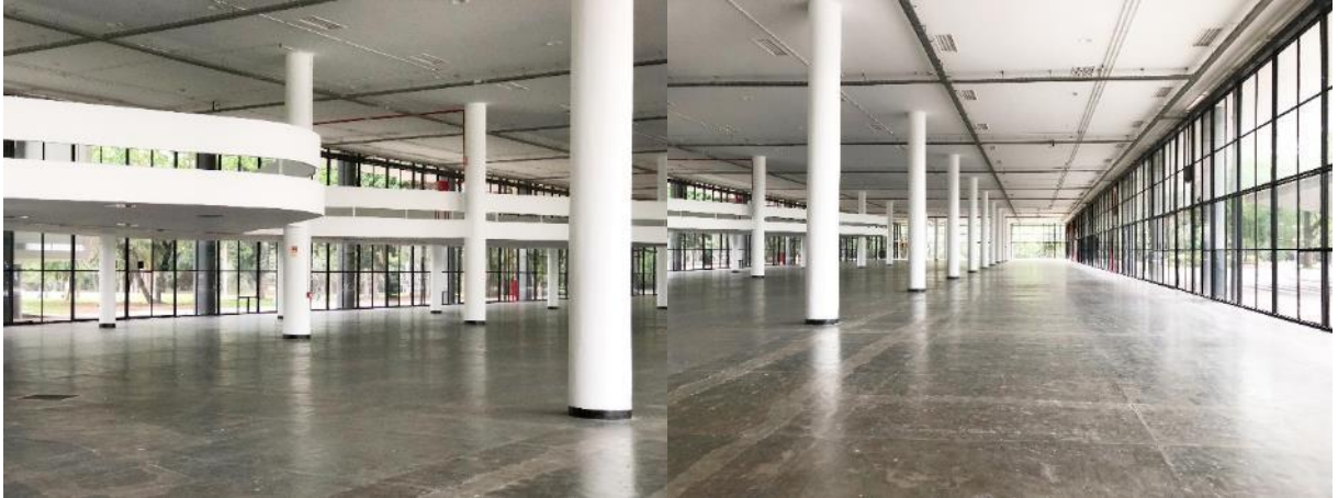
Figura 44: Mezanino do Pavilhão com guarda-corpo em fita (esq.) e pé direito duplo e pano de vidro no pavimento térreo (dir.) | São Paulo Fonte: AUTOR
