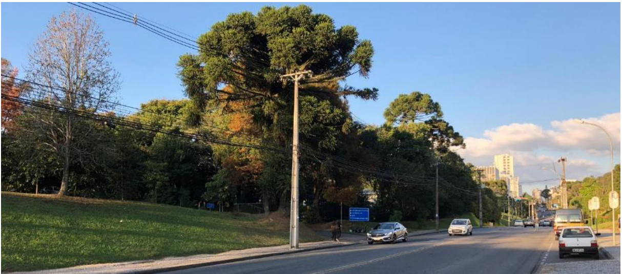
Figura 69: Levantamento fotográfico | Foto 6 Fonte: AUTOR
