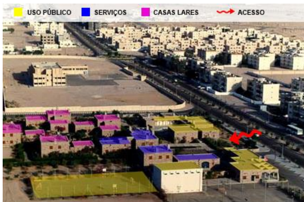
Figura 16– Foto aérea da SOS Children's Village com a marcação dos setores internos Fonte: DAMLUJI, Salma S. (2001) adaptado pela autora
