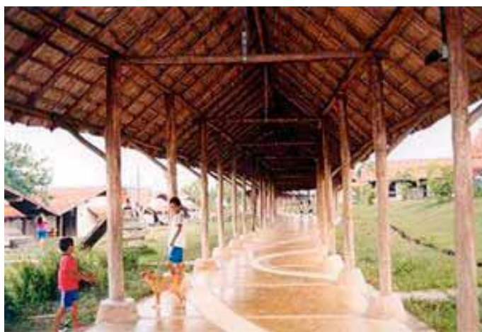
Figura 11– Circulação central da Aldeia Infantil SOS Manaus com cobertura em palha. Fonte: LIMA (2014)
