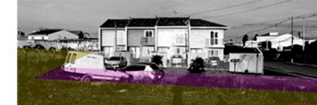
condição atual da Rua Ipê Amarelo avanço de 20 metro dentro da quadra.
