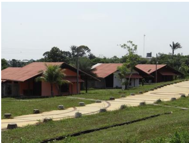
Figura 13– Circulação central da Aldeia Infantil SOS Manaus após a retirada da cobertura em palha.
