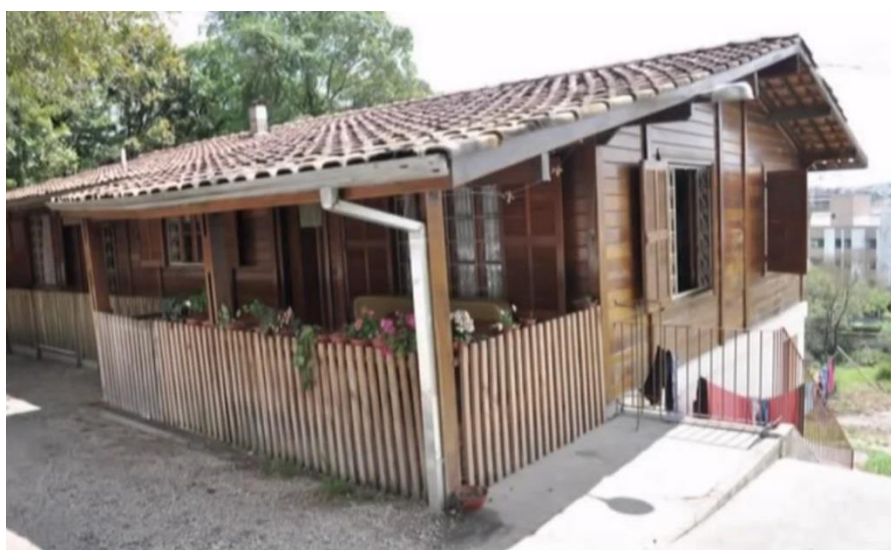
Figura 22– Casa lar com o pavimento superior em madeira. Fonte: Arquivo ACRIDAS (2014)
