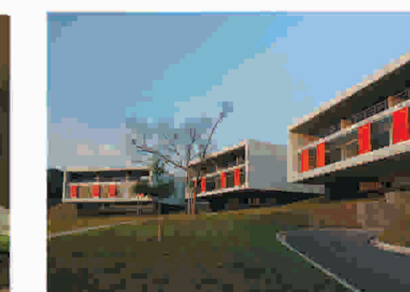
Parque Biblioteca León de Grieff Giancarlo Mazzanti
