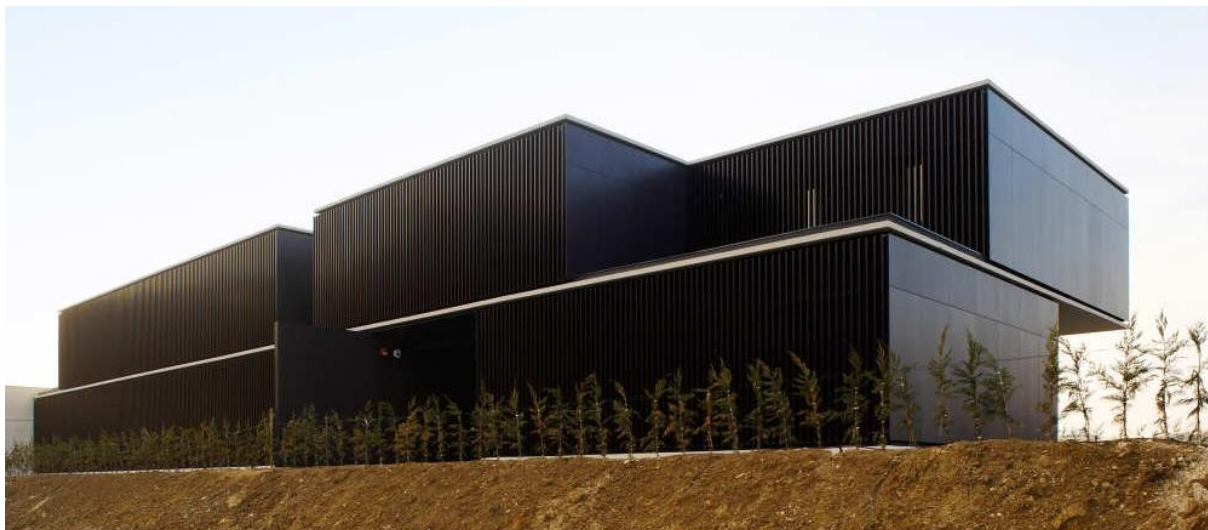
Figura 17 – Fachada composta por perfis de alumínio.
