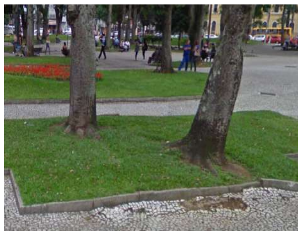
Fotografia 9 - Canteiro e calçamento degradados pelas raízes da árvore Fonte: elaborado pelo autor, em maio de 2017.
