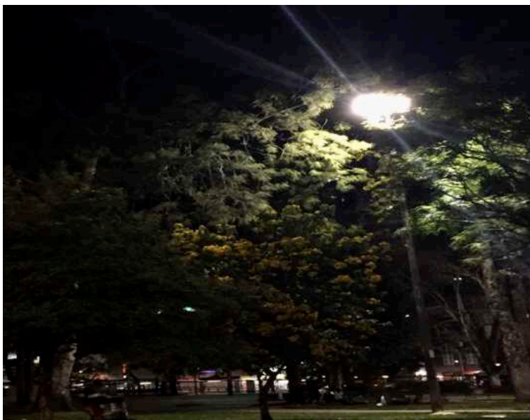
Fotografia 22 - Iluminação Inadequada e Bloqueada Fonte: elaborado pelo autor em 2017.
