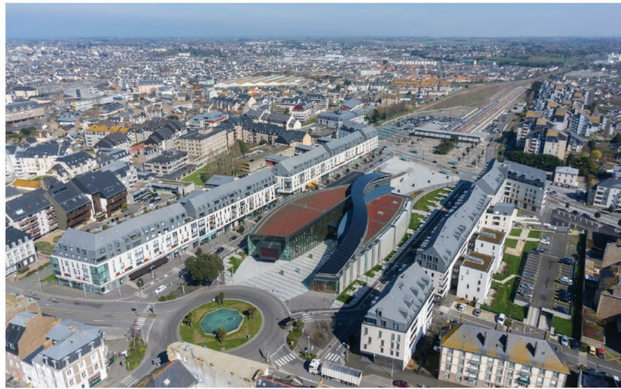
A Grande Passarela - A. S. Architecture
