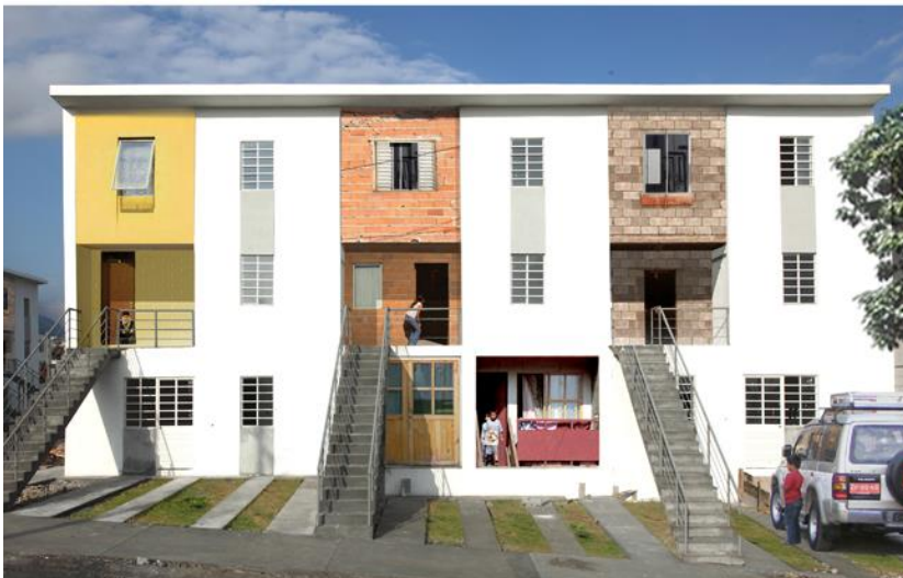
Figura 11 – Fachada depois de alterada pela expansão de seus moradores das Viviendas .
