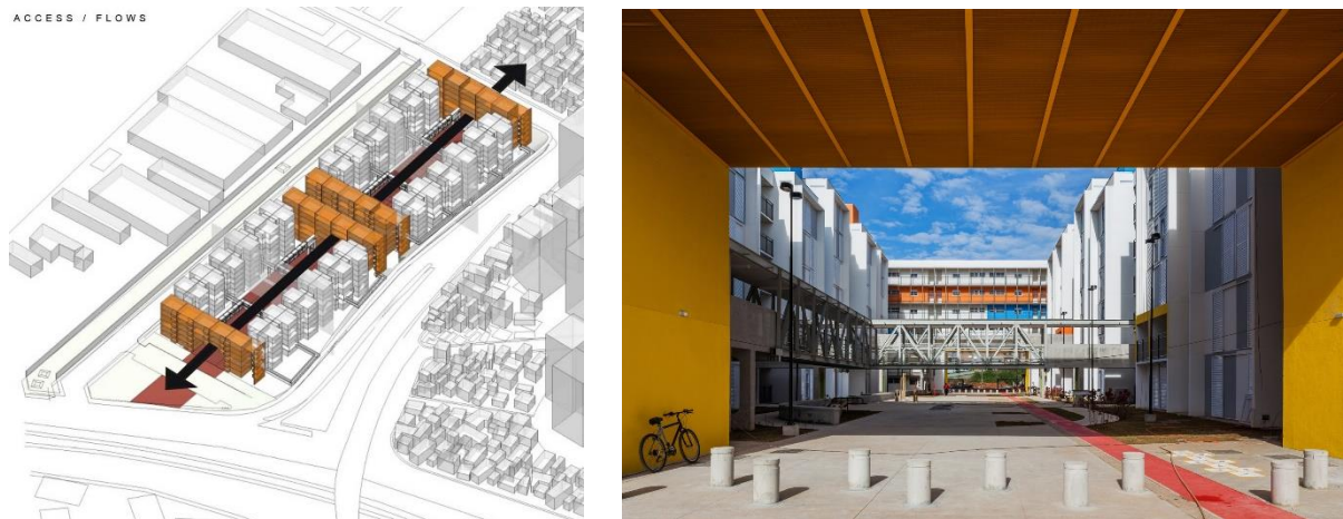
Figura 13 –Diagrama de acessos ao pátio central (à esquerda); Foto do pátio central visto a partir do pórtico de entrada.
