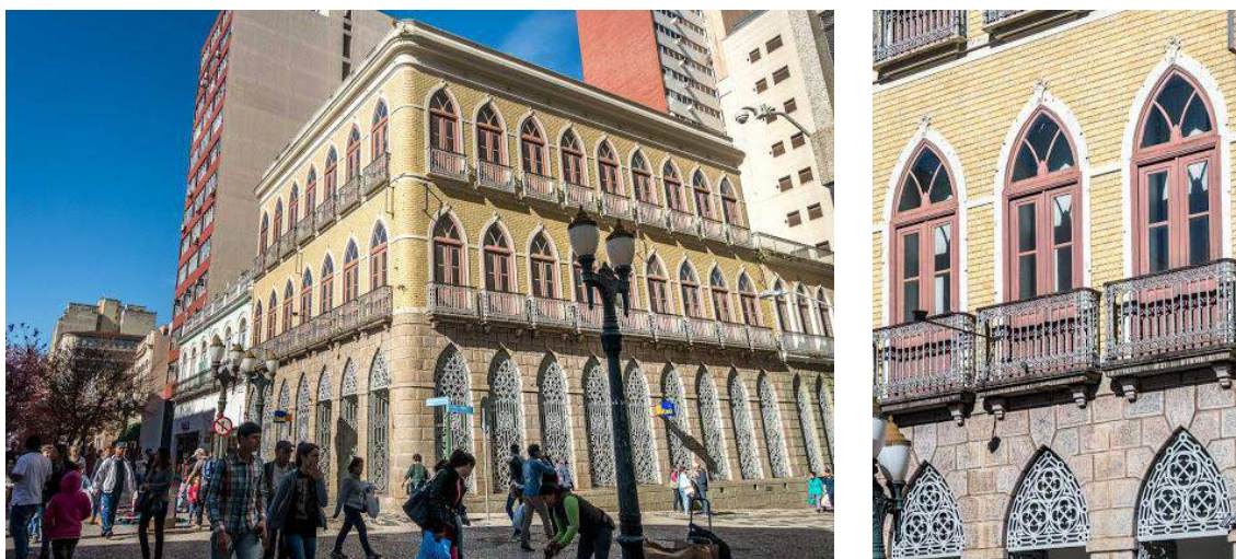
Figura 48: Edifício Manoel da Costa Cunha.
