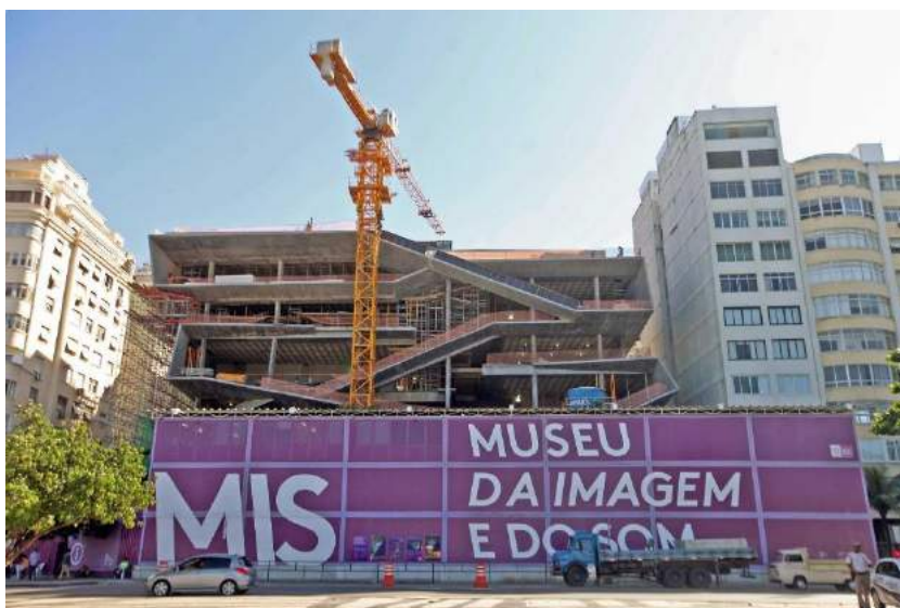
Figura 28: MIS Rio em obras
