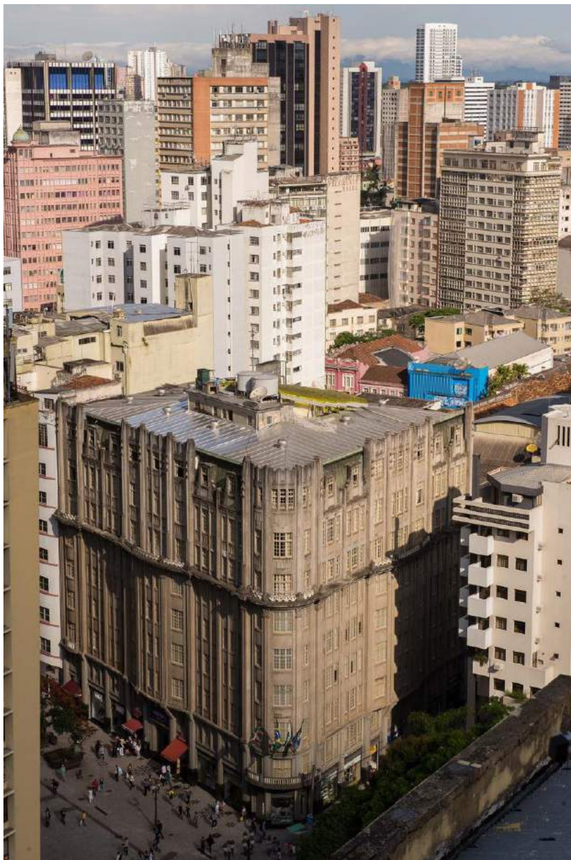
Figura 51: Vista aérea do Edifício Moreira Garcez
