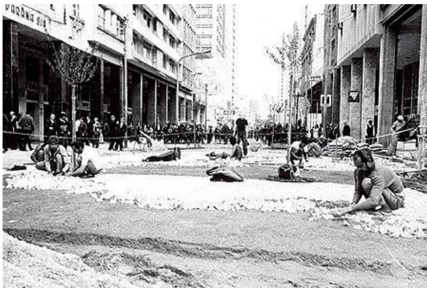
Figura 37: Construção do Calçadão da Rua das Flores
