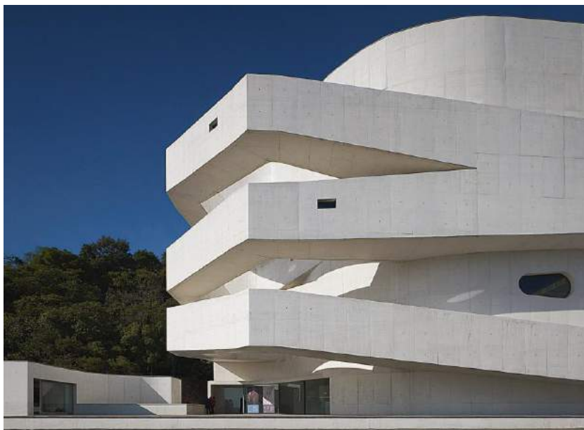
Figura 19: Rampas em balanço marcam a fachada do edifício, FIC
