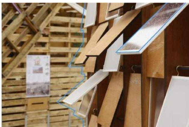
Figura 55 Detalhe do revestimento externo do abrigo.
