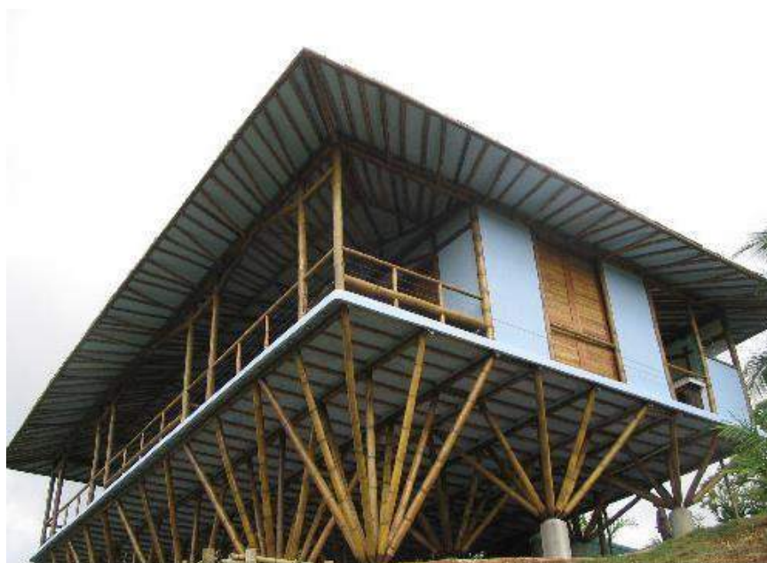
Fotografia 21 - Residência sob estrutura de bambu autoclavado
