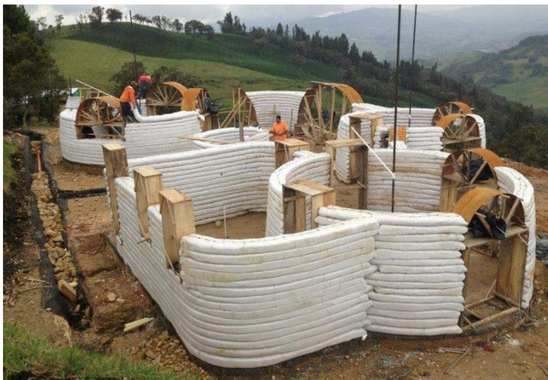
Fotografia 9 - Processo de construção com hiperadobe
