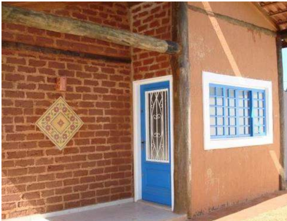
Fotografia 8 - Exemplo de parede construída com blocos de adobe
