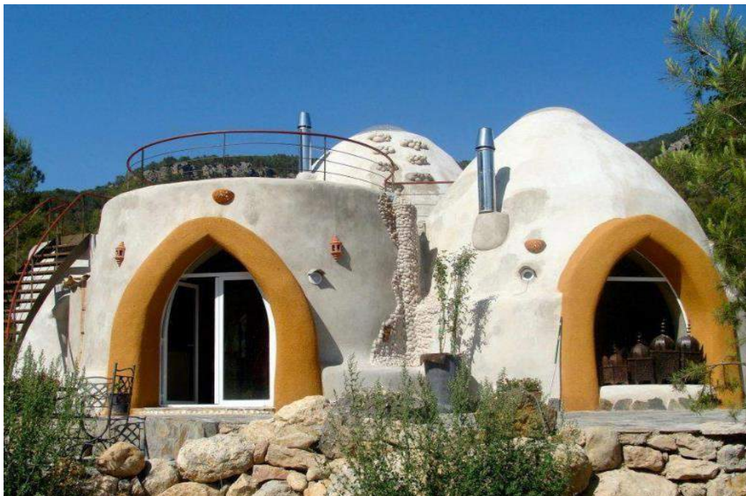
Fotografia 10 - Edificação de hiperadobe
