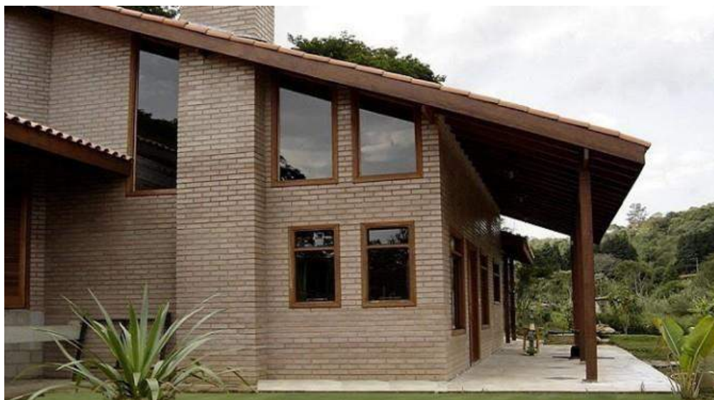
Fotografia 12 - Residência de blocos de solo-cimento
