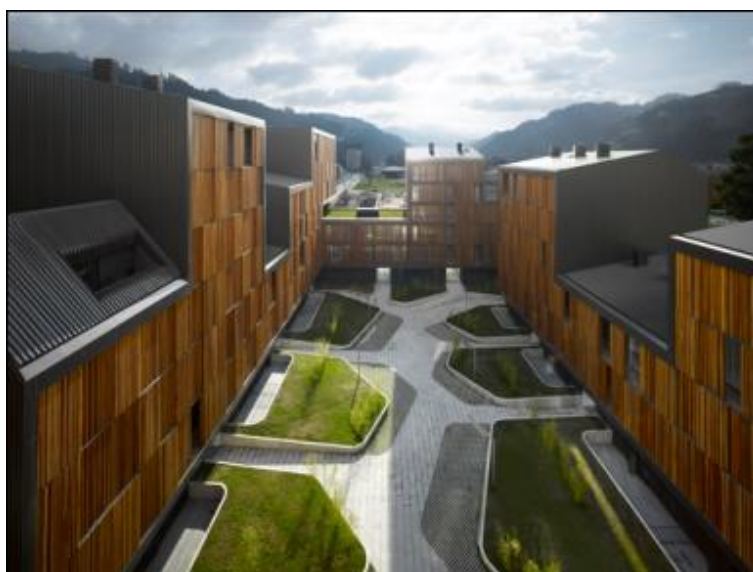
Figura 19 – Foto da praça interna da Habitação Social Vivazz Fonte: ZigZag Arquitectura, 2006.
