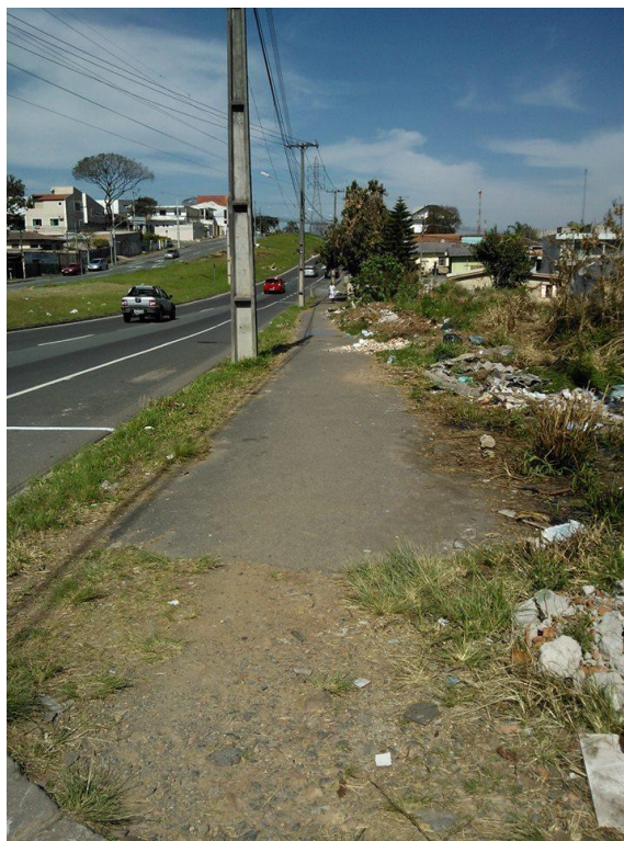
Figura 34 – Ciclovía na Avenida das Indústrias, na Cidade Industrial de Curitiba. Fonte: A autora.
