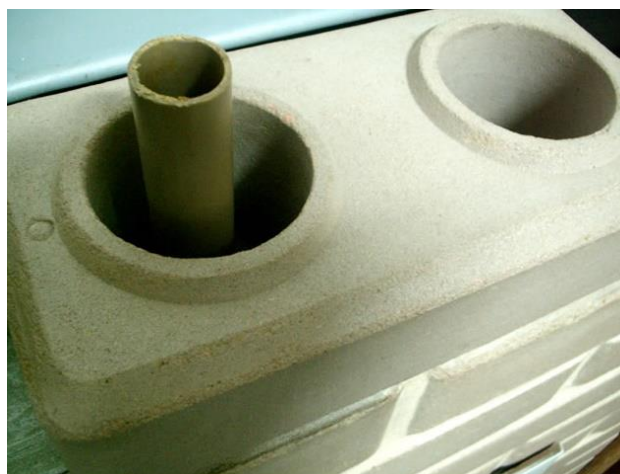
Figura 4 - Rede Hidráulica Embutida Fonte: Adaptado casaPRO(2010).
