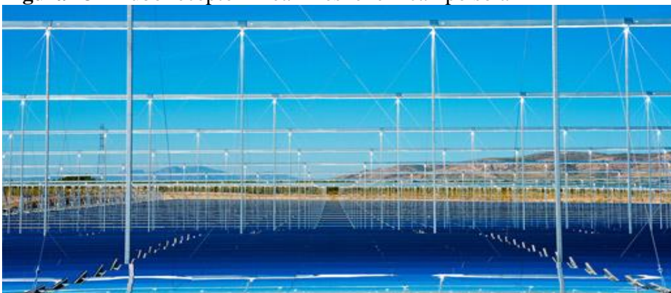
Figura 13 – Tubo receptor linear Fresnel em campo solar
