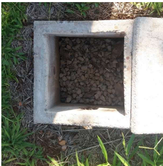
Figura 9 - Haste convencionalmente aterrada
