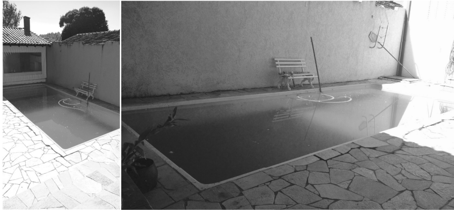
Fotografia 22 – Piscina no estado inicial.
