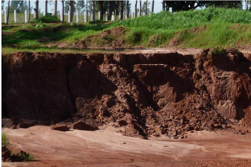
**Figura 26 – Área da célula em operação afetada por drenagem ineficiente de águas pluviais**
