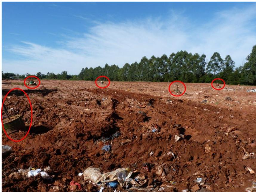
**Figura 31 – Drenos e queimadores de Gás do Aterro de Paranaíba.**
