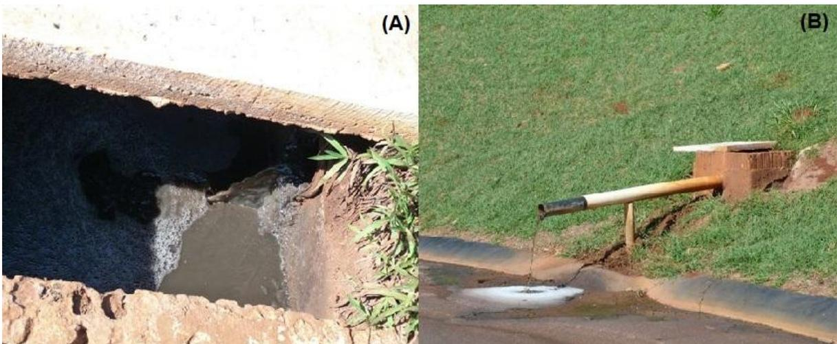
Figura 35 – Drenagem de Chorume do Aterro Sanitário de Paranavaí. (A) Poço de Recebimento de Chorume; (B) Poço de Recebimento de Chorume com a Condução para a Lagoa de Tratamento.
