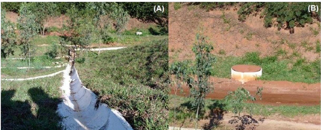
Figura 34 – Sistema de Drenagem Definitiva do Aterro Sanitário de Paranavaí. (A) Canaletas de Coleta de Água; (B) Poço de Acumulação.
