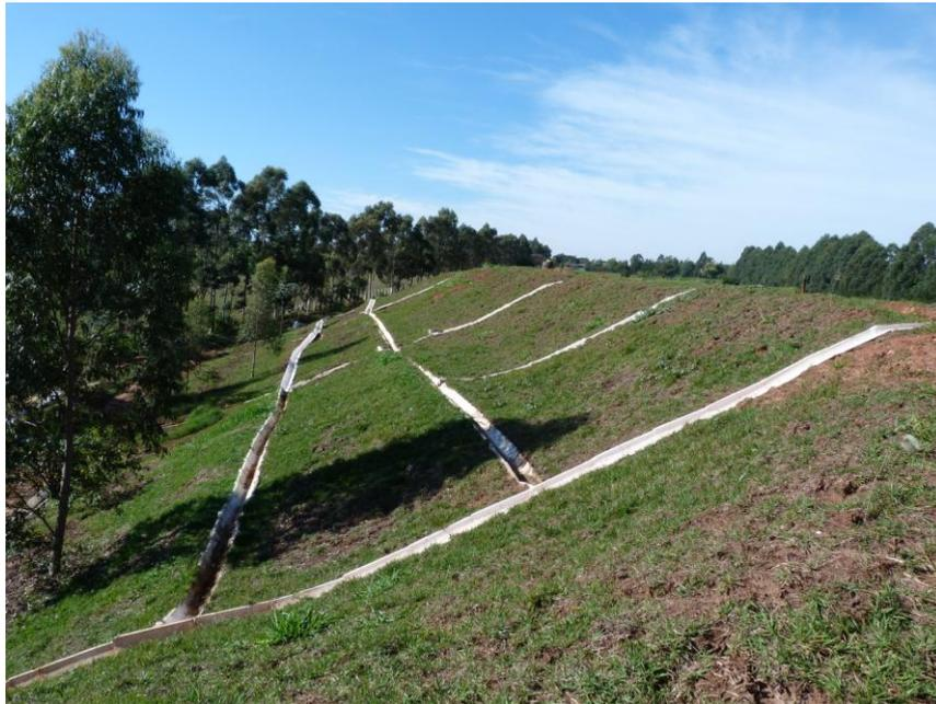
**Figura 25 – Sistema de Drenagem Definitiva do Chorume do Aterro Sanitário de Paranaváí.**
