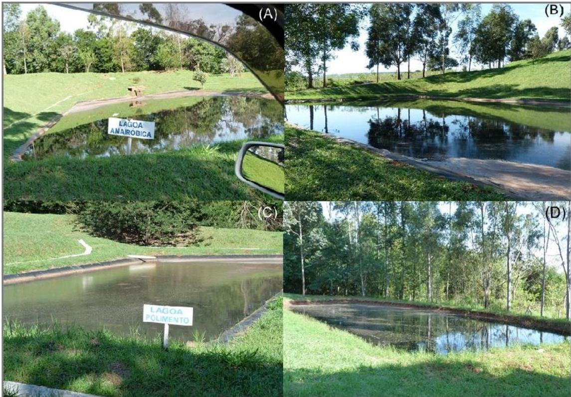
**Figura 29 – Sistema de Tratamento do Aterro Sanitário de Paranavaí. (A) Lagoa Anaeróbia; (B) Lagoa Facultativa; (C) Lagoa de Polimento; (D) Lagoa de Infiltração.**
