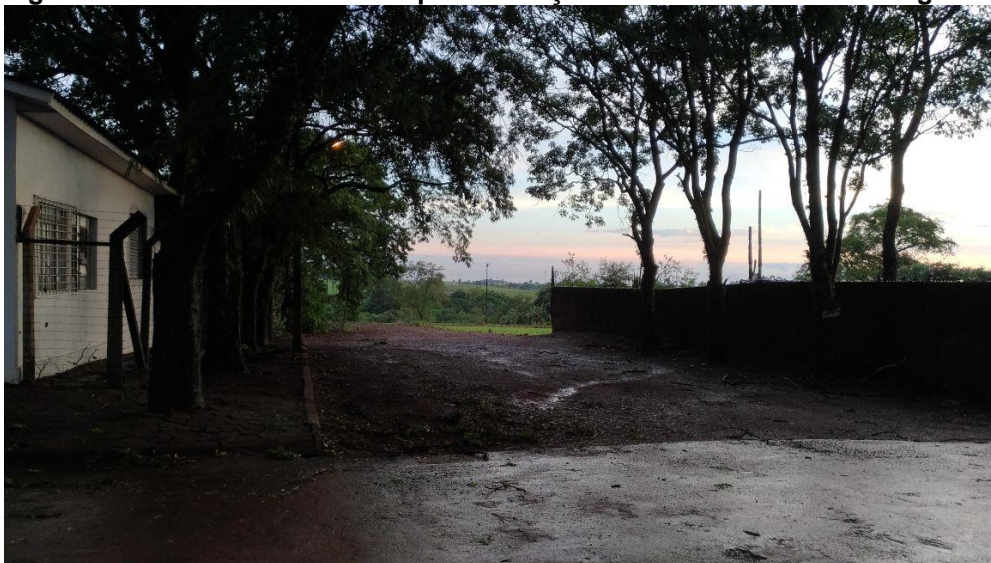
Figura 8 – Rua com ausência de pavimentação e infraestrutura de drenagem urbana.
