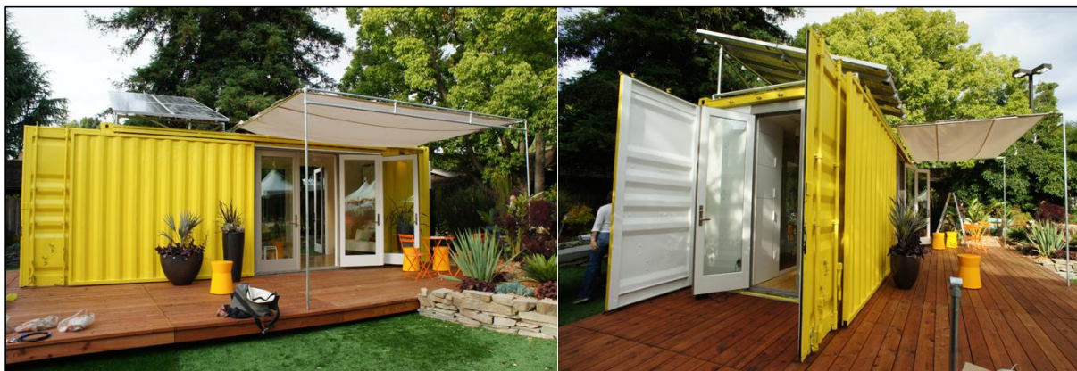
Figura 15 - Casa contêiner com sistema de aquecimento solar Fonte: Hybrid Architecture (2015).
