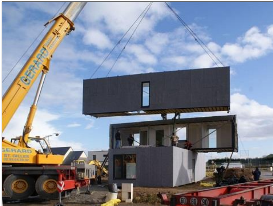
Figura 3 - Recebimento e encaixe de estruturas de contêiner realizado com auxílio de um guindaste Fonte: CG Architectes (2015)
