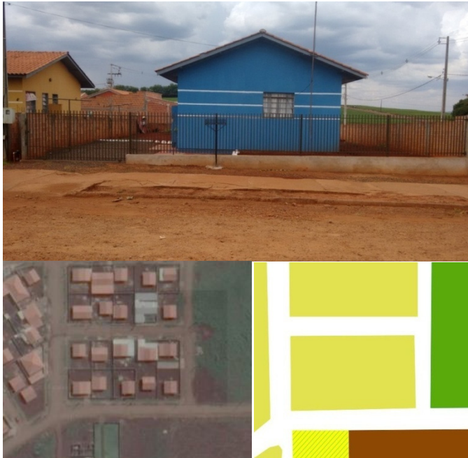
Figura 6 - Exemplo da classe "Edificação de até 4 pavimentos sem vegetação", encontrada na área urbana do município de Fênix – PR. Fonte: Autoria própria.
