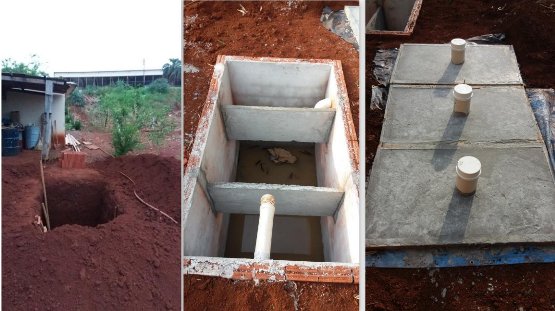
Figura 11 - Construção Fossa Séptica (2017).
