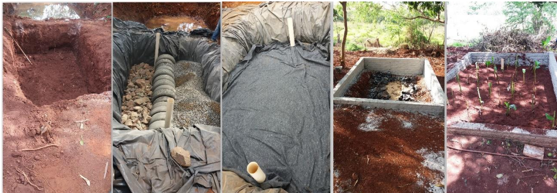
Figura 12 - Construção da Bacia de Evapotranspiração (2017)
