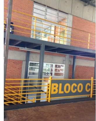
Figura 5 – Bloco C Outdoor Fonte – Autoria própria
