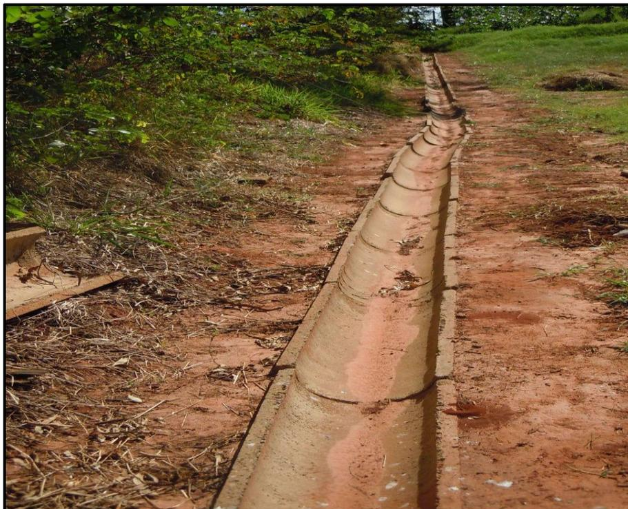
**Figura 22: Drenagem definitiva de águas pluviais**
