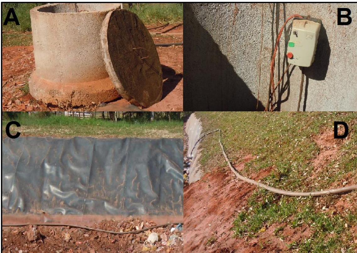
Figura 21: (A) poço de acumulação do chorume, (B) Controle da moto Bomba, (C) Tubo de PVC no interior da vala, (D) Tubo de PVC que encaminha chorume do poço até a vala. Fonte: Autoria própria, 2015.
