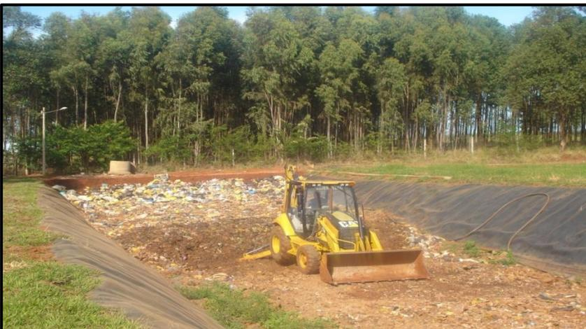
**Figura 17: Recobrimento dos resíduos**
