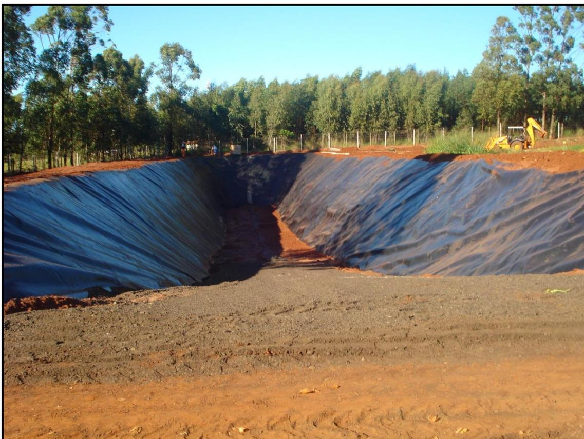
Figura 20: Impermeabilização do Aterro
