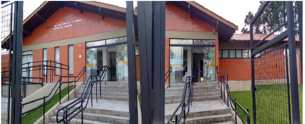
Figura 1 - Fachada principal do Ministério Público do Trabalho Fonte: Autoria Própria
