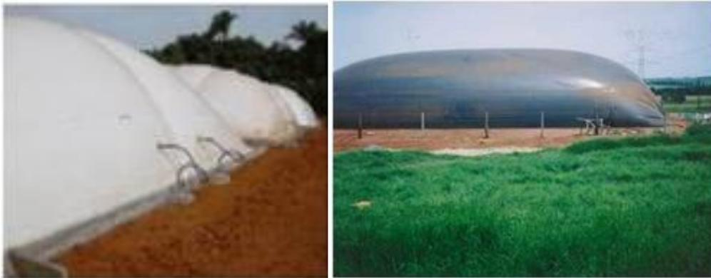
**Figura 2. Biodigestor Modelo da Marinha.**
