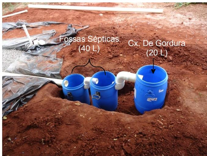
**Figura 5 - Foto da caixa de gordura seguida das fossas sépticas do sistema de leito cultivados instalado na propriedade rural em Florái, PR.**
