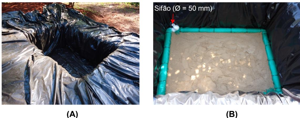
**Figura 6 - Etapa inicial da construção do leito cultivado na propriedade rural em Florai, PR. (A) - impermeabilização da unidade de leito cultivado. (B) – rede de tubulação coletora dos efluentes pré -tratados revestidas por sombrite.**
