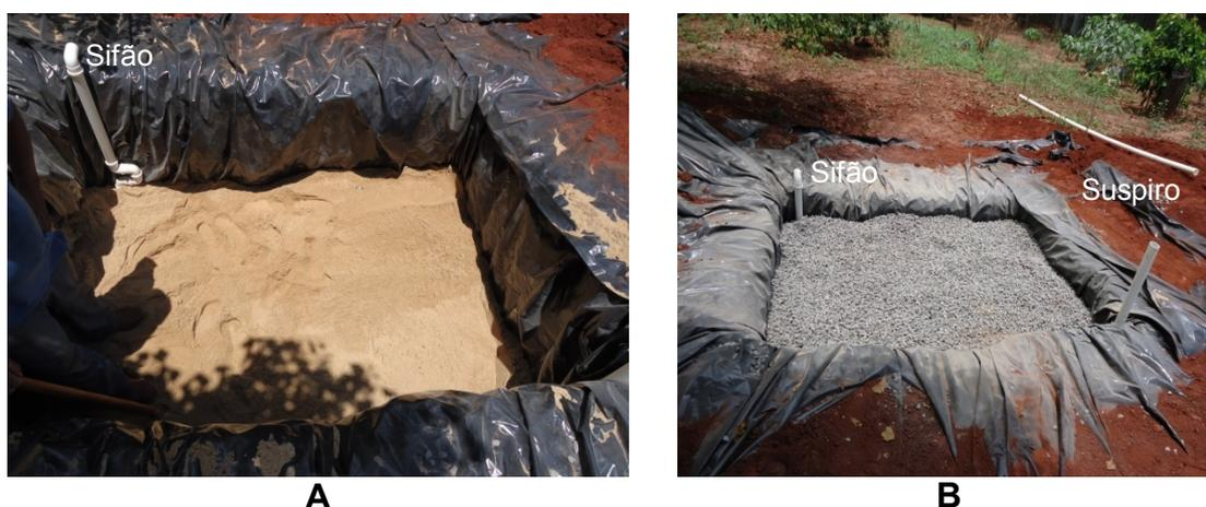
**Figura 7 - Materiais utilizados no interior do leito cultivado instalados na propriedade rural em Florai, PR. a- camada de areia média. b- camada de brita.**
