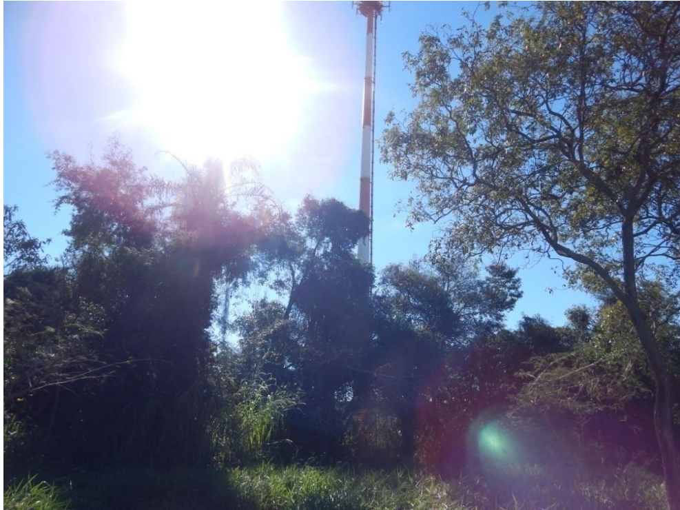
Figura 5- Vista frontal da torre de telecomunicação, a partir da rodovia BR- 369, no município de Campo Mourão- PR.
