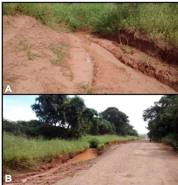
**Figura 12 – A) Presença de sulcos formados pela ação da água; B) Desvio para escoamento de água nas margens da BR 487, Tuneiras do Oeste - Paraná.**
