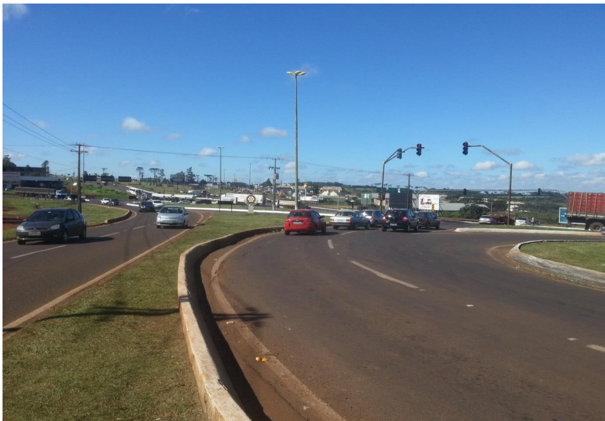
Figura 5 – Ponto de monitoramento localizado no entroncamento da BR 277, PR 369 e PR 467 com a Avenida Brasil.
