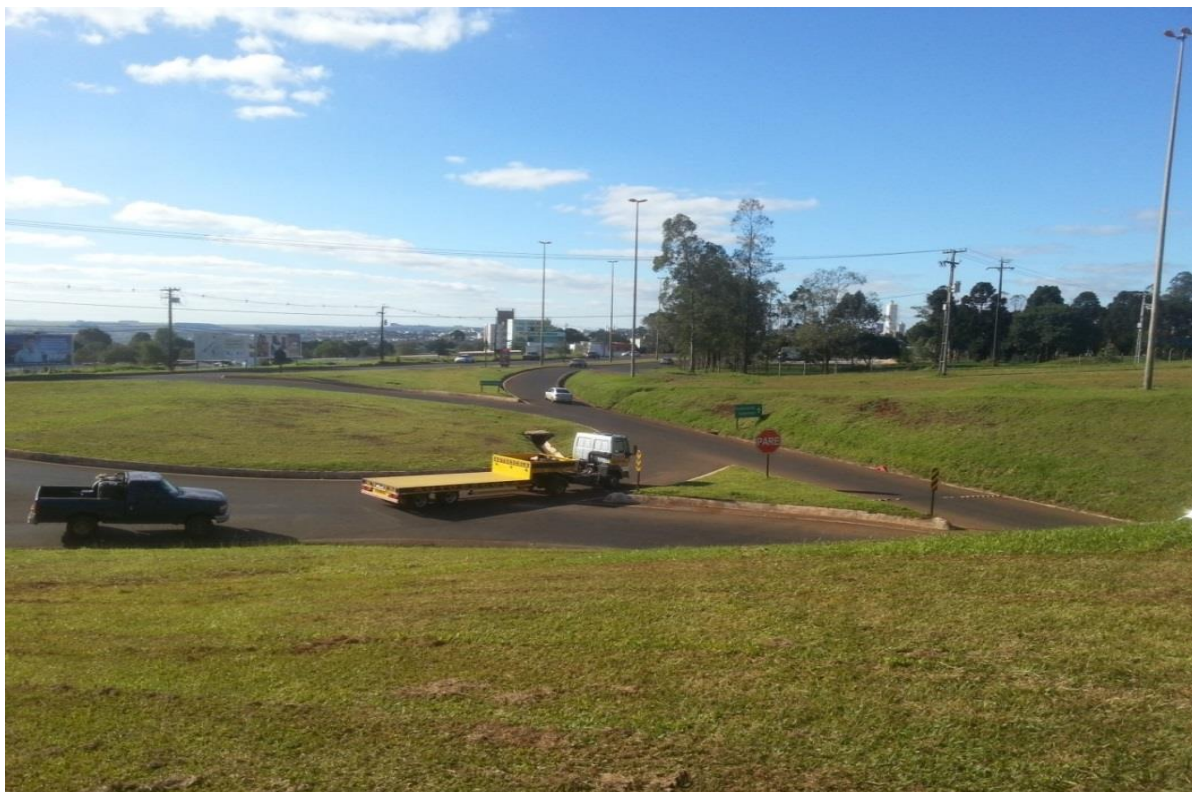
Figura 13 – Ponto de monitoramento localizado no entroncamento da Avenida Tancredo Neves e Rua Tito Muffato com a BR 277.
