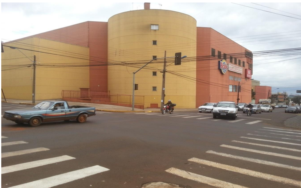
Figura 11 – Ponto de monitoramento localizado no cruzamento da rua Jorge Lacerda com a rua Recife.
