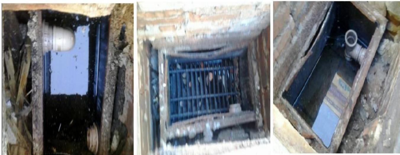
**Figura 9 – Sistema Caixa SAO de três componentes.**
