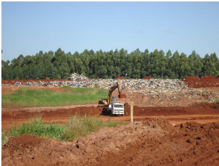
Figura 9 – Vista do Aterro Sanitário Municipal de Campo Mourão.
