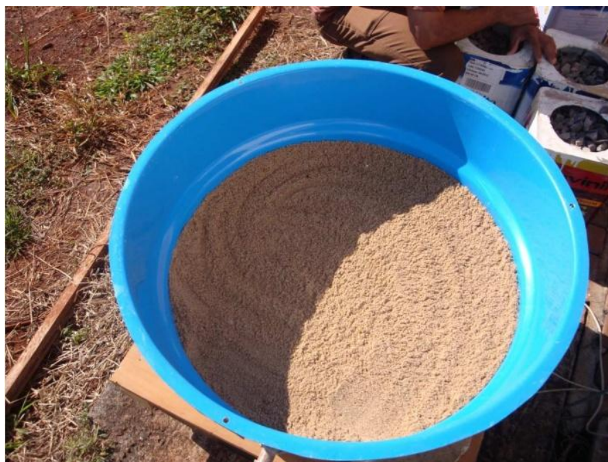
Figura 7 - Caixa d'água para implantação das macrófitas coberta por areia.
