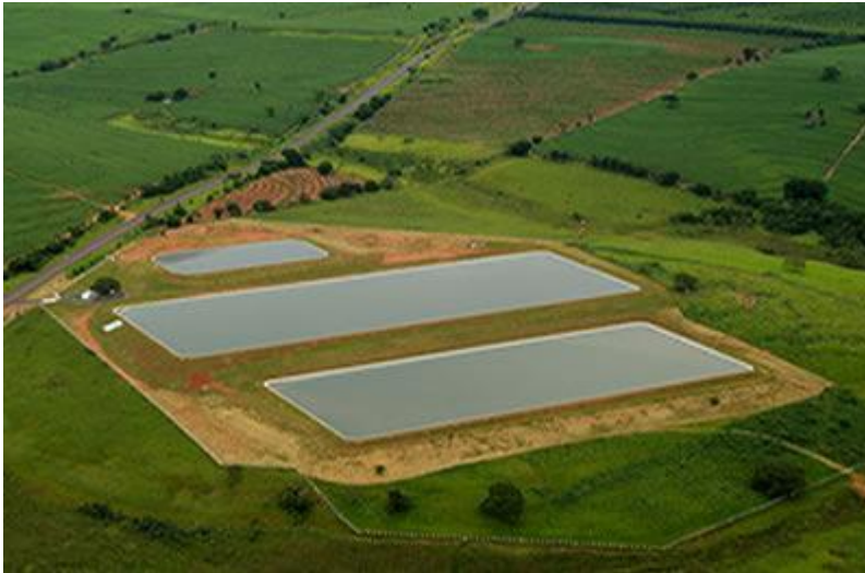
Figura 1- Lagoa anaeróbia seguida de lagoas de estabilização.
